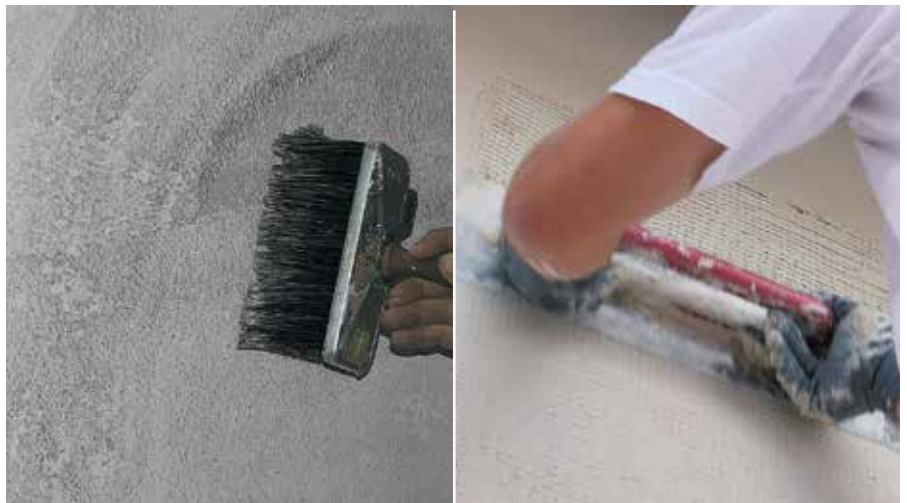
Učvršćivanje podloge s RÖFIX PP 201
