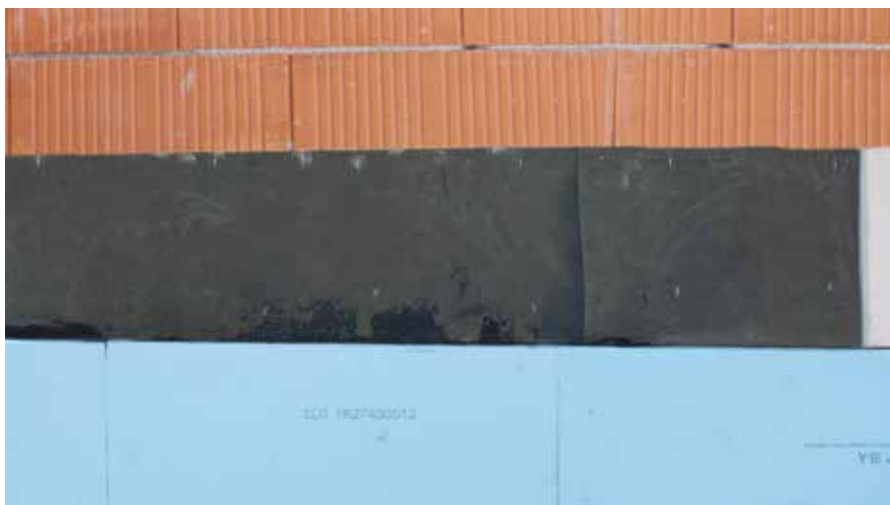
XPS-perimetarne izolacijske ploče lijepe se na bitumenske trake korištenjem RÖFIX 1K Plus bitumenskog hladnog ljeplila
