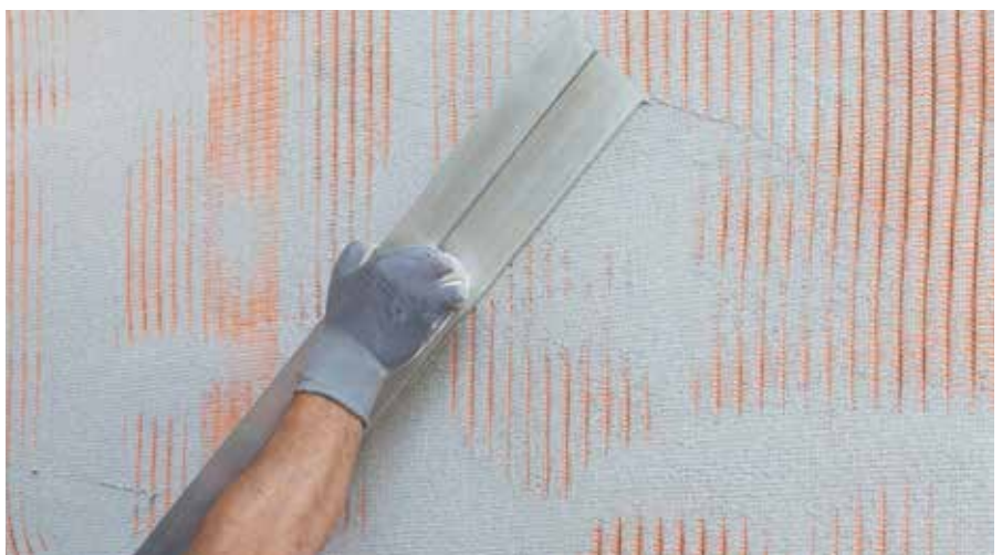
Umetanje RÖFIX P50 staklene mrežice u svježe pročešljani mort
