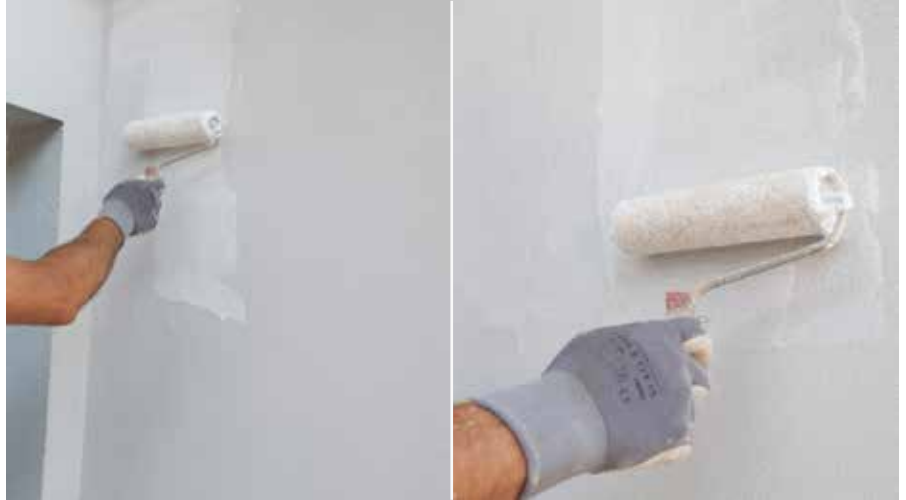
Temeljito nanijeti RÖFIX Predpremaz PREMIUM i ostaviti da se suši najmanje 24 h
