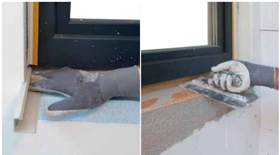
RÖFIX SOL-PAD priključni profil za prozorske klupčice zalijepiti RÖFIX POLYMER-om, zatim površinu izolirati s RÖFIX OPTIFLEX® 1K ili 2K
