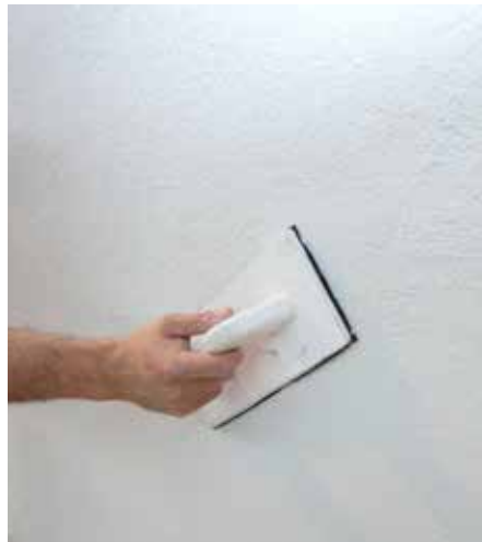
Strukturiranje RÖFIX Renopor® Specijalnim ljepilom
