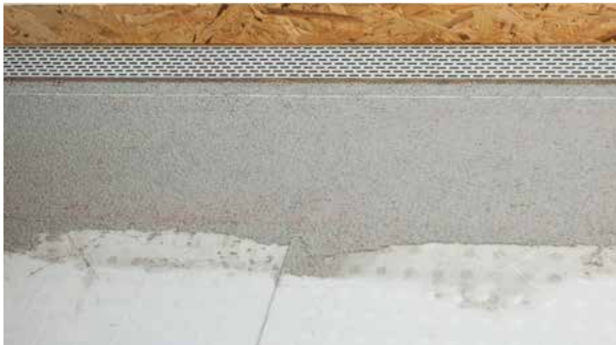
RÖFIX završni profil krova umetnuti u prethodno naneseeni mort za lijepljenje i armiranje
