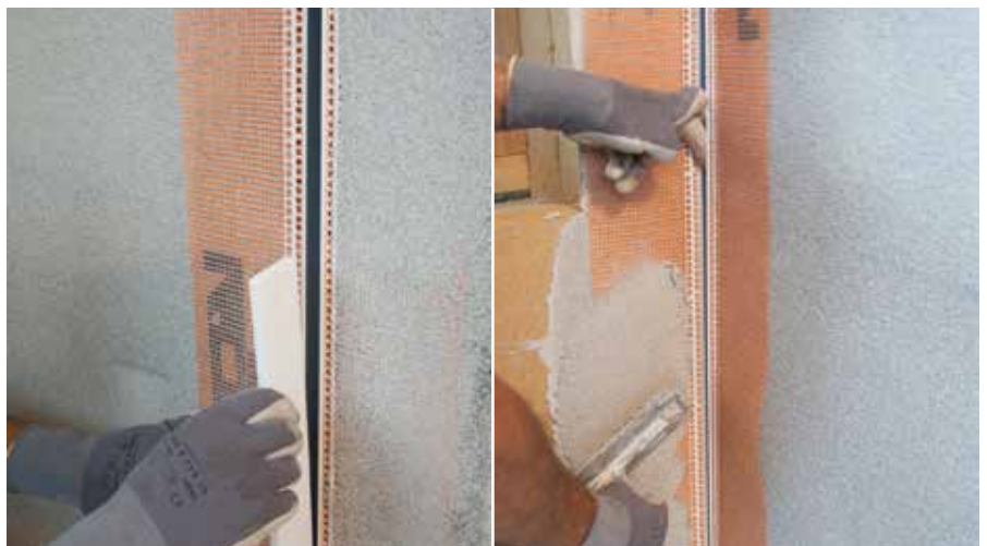
RÖFIX Profil dilatacijske fuge E-forme
