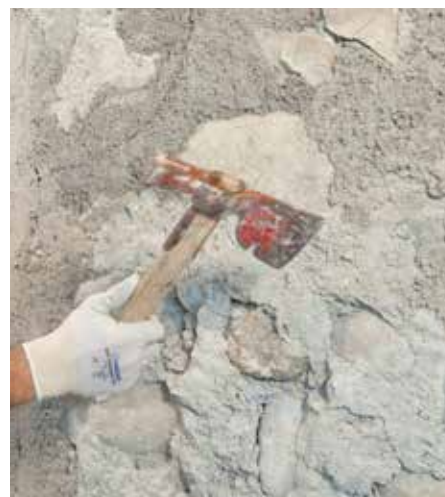
Obijanje stare žbuke
