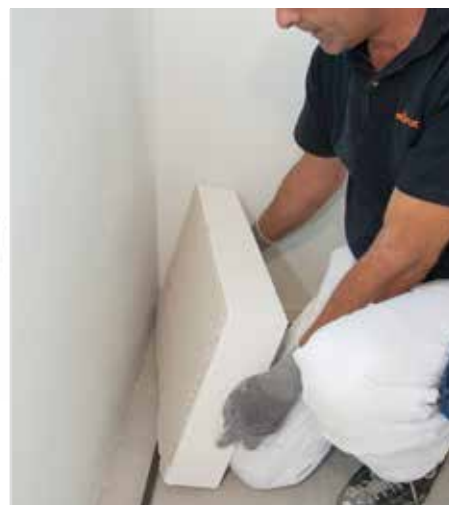
Izolacijske ploče dobro utisnuti u podlogu
