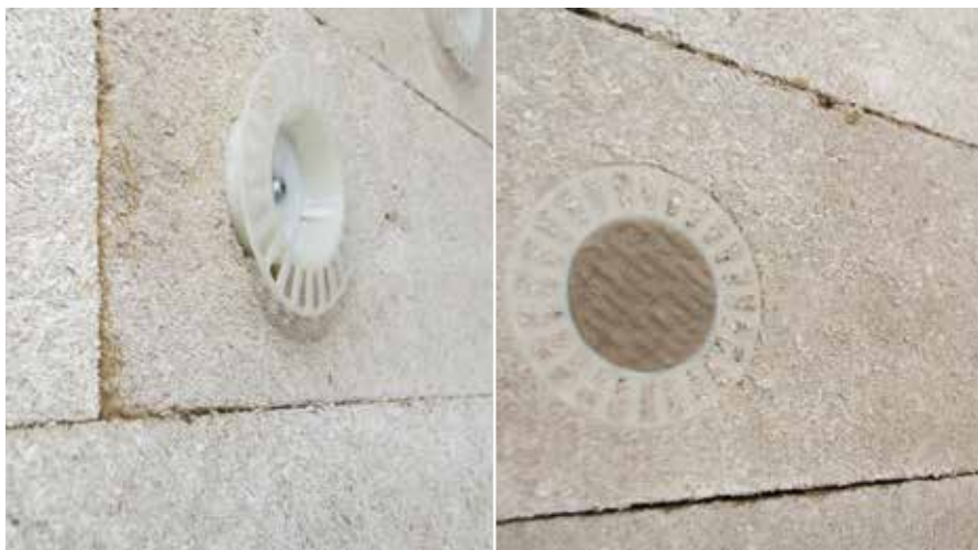
Uronjiva montaža izolacijskih lamela od mineralne vune najlakše se izvodi RÖFIX VT2G- tanjurićem za uronjivu montažu
