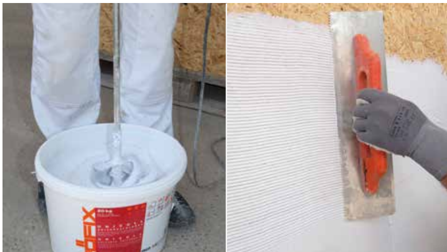
RÖFIX UNICOLL nanosi se tankoslojno i punoplošno i češlja gleterom. Ostaviti da se dobro osuši
