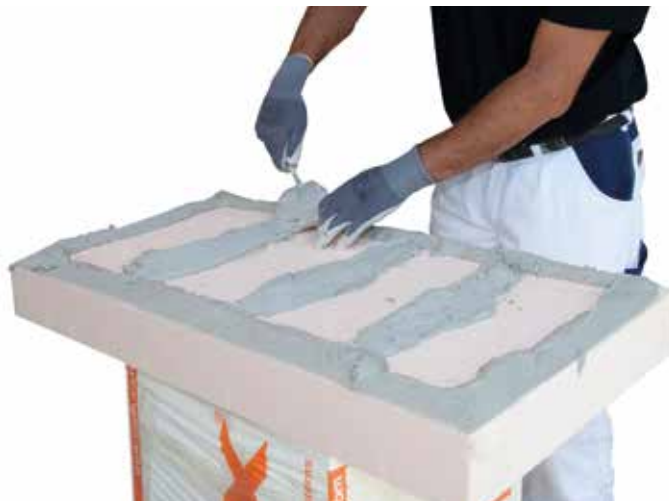
60 %-tno nanošenje ljepila na površinu ploče
