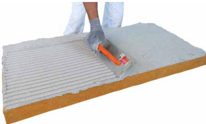
Lijepljenje postupkom „Floating-Buttering“ (punoplošno na poledinu izolacijske ploče i površinu gdje se lijepi ploča)
