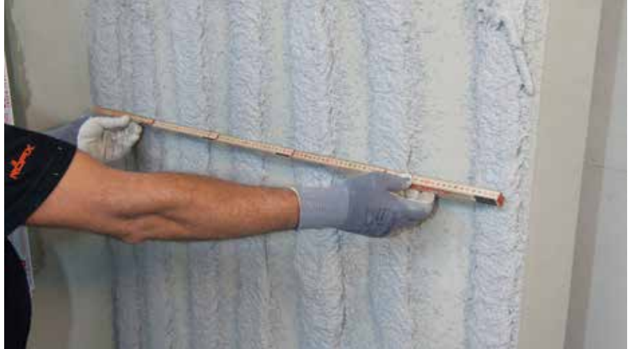
Širina traka nanesenog morta 5–6 cm i razmak od 11 cm između traka nanesenog morta
