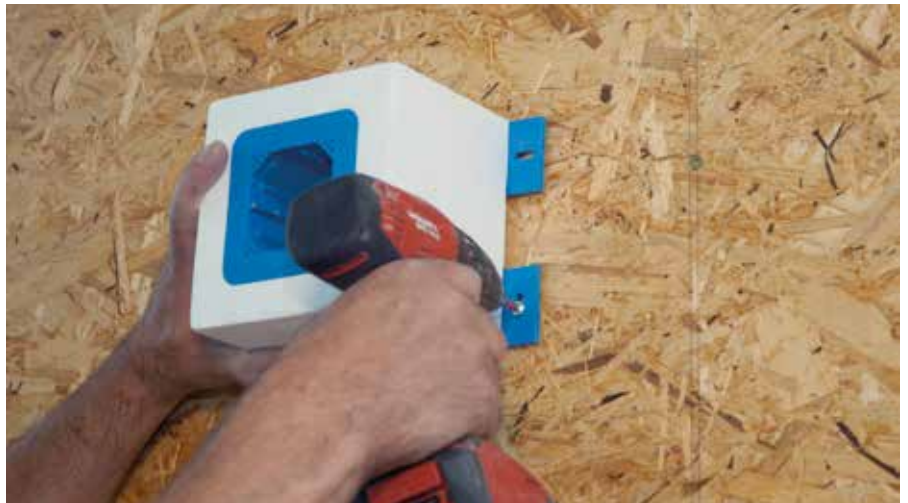
Pričvršćivanje montažnog elementa
