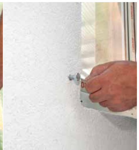
Vijčano pričvršćivanje montažnog elementa M-vijkom
