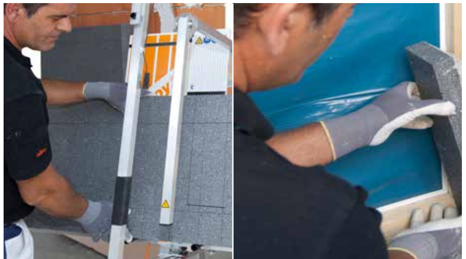
Rezanje ploča RÖFIX Isoboy EX 34-K kutnim rezačem
