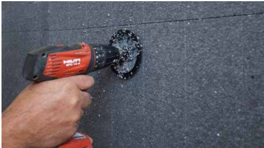
Izvođenje otvora RÖFIX Dorondo - alatom za glodanje
