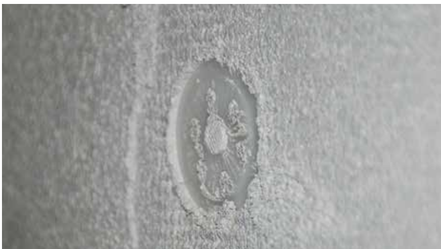
Pričvršćivanje u svježi armaturni sloj
