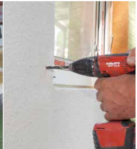
Bušenje rupe odgovarajućim svrdlom
