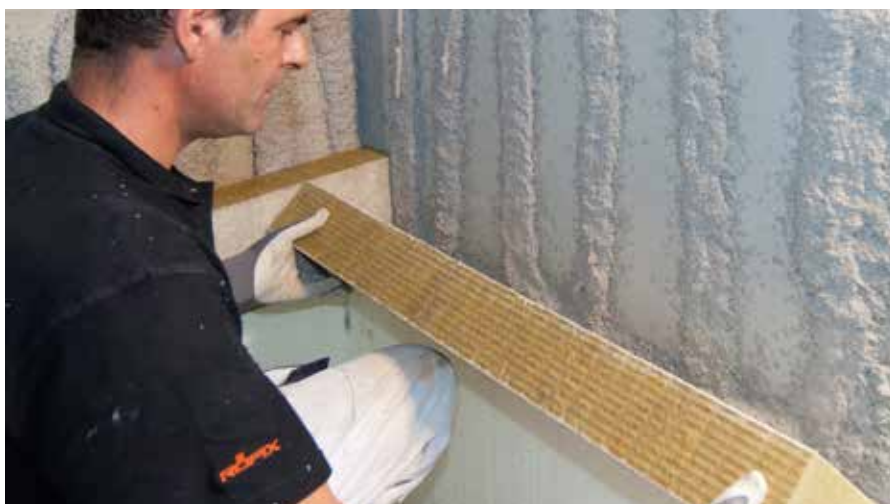
RÖFIX Speed izolacijske lamele od mineralne vune utiskuju se u svježe nanoseni mort za lijepljenje u obliku linija
