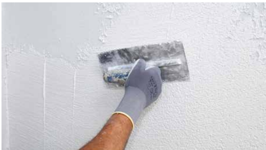
Nanošenje RÖFIX SiSi®žbuke bijela i strukturiranje
