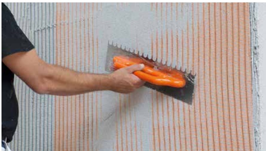
Nanošenje RÖFIX Unistar® LIGHT-a u nazivnoj debljini od 5 mm
