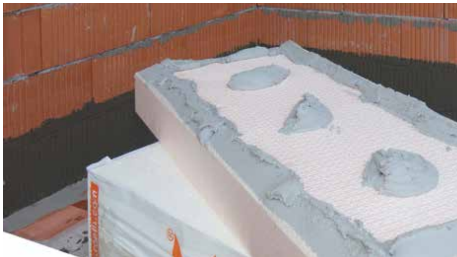
Lijepljenje RÖFIX EPS-P 035 Izolacijskih ploča za podnožje s RÖFIX Optiflex® 1K ili 2K
