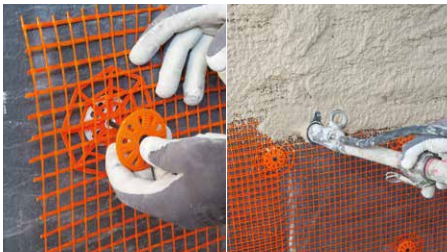
RÖFIX AR Zaštitnu mrežu postaviti i pričvrstiti korištenjem RÖFIX BTH i RÖFIX NDF
