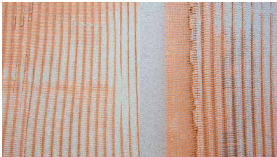
Ispod VOSS \leq 20 % površina se dvostruko armira s dva sloja RÖFIX P50
