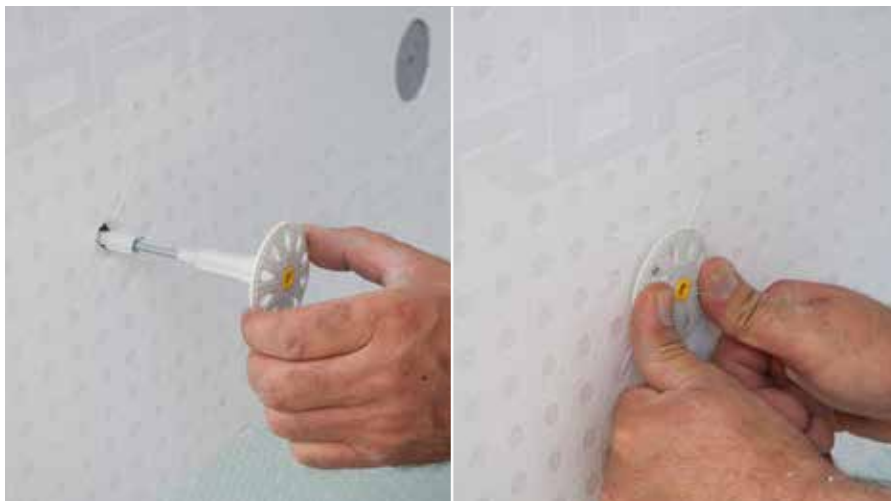
RÖFIX ROCKET utaknuti da tanjurić pričvršnice bude u ravni s izolacijskom pločom
