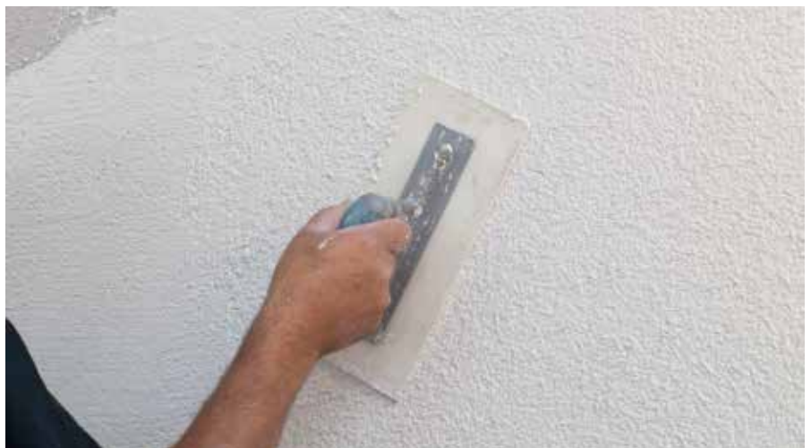
Strukturiranje završne žbuke
