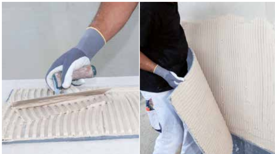
Ljepilo masivno nanijeti na izolacijsku ploču i pročešljati, postupak ponoviti na podlozi te potom izolacijsku ploču utopiti u podlogu
