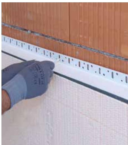
Pričvršćivanje RÖFIX baznog priključnog profila za podnožja
