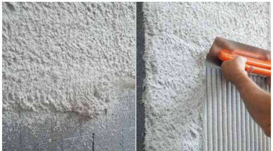
Strojno nanošenje morta
