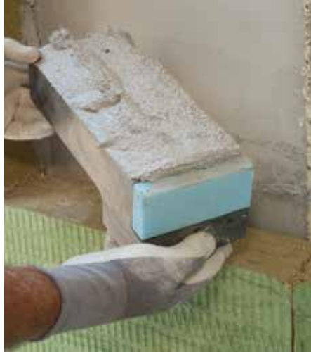
RÖFIX K1-PH punoplošno prekriti ljeplilom
