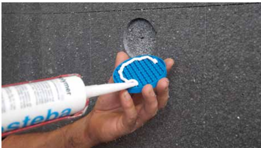
Nanošenje PU-ljepila
