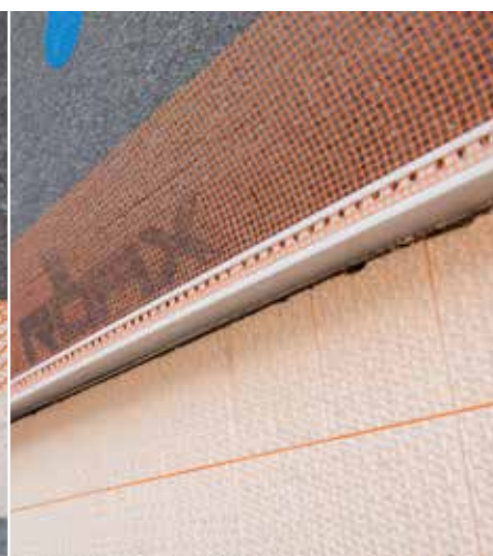
Izgled završenog, nepropusnog spojnog profila za podnožja s ugrađenim okapnim profilom prije žbukanja
