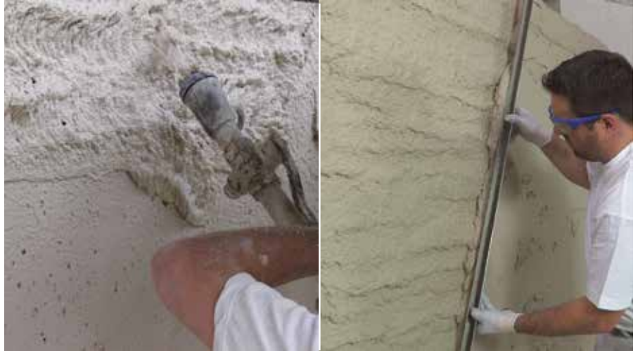
Nanošenje i izvlačenje/poravnavanje FIXIT 222 Aerogel izolacijske žbuke
