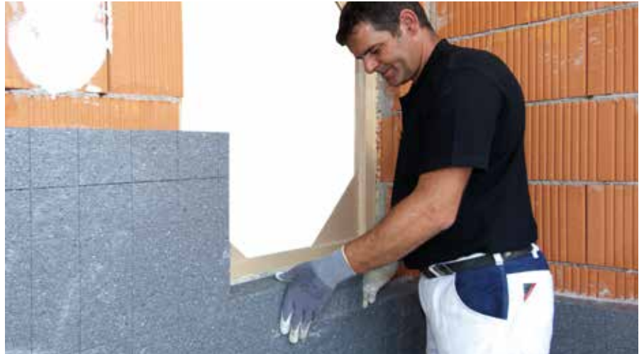
Postavljanje izolacijskih ploča oko kutova otvora u obliku slova L
