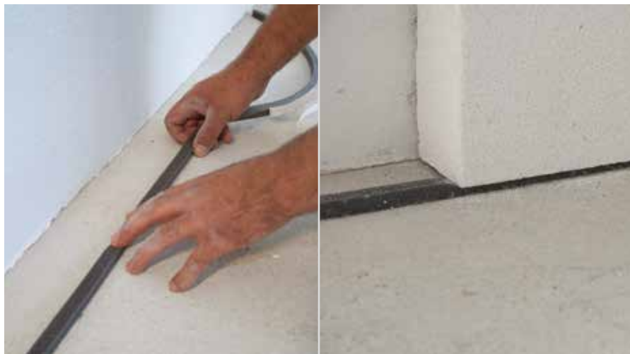
Unutarnji izolacijski sustav se u podu, stropu i zidu zatvara RÖFIX izolacijskom trakom za fuge
