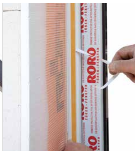
RÖFIX Mini 3D zalijepiti na prozorske okvire a prozor prije žbukanja oblijepiti radi zaštite
