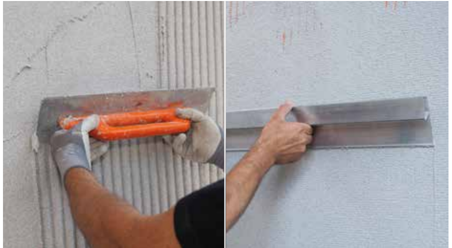
Nanošenje morta zubčastim gleterom u ravnim linijama i utiskivanje RÖFIX P50 staklene mrežice. Izravnavanje površine aluminijском letvom
