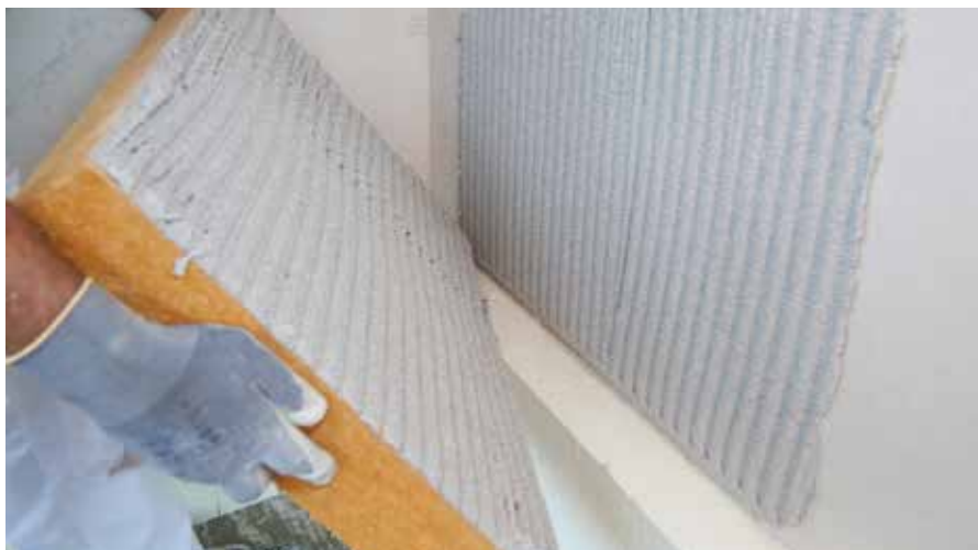
Postavljanje izolacijskih ploča sistemom „svježe u svježe“
