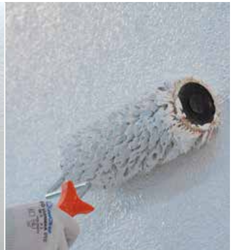
Premaz paropropusnim bojama
