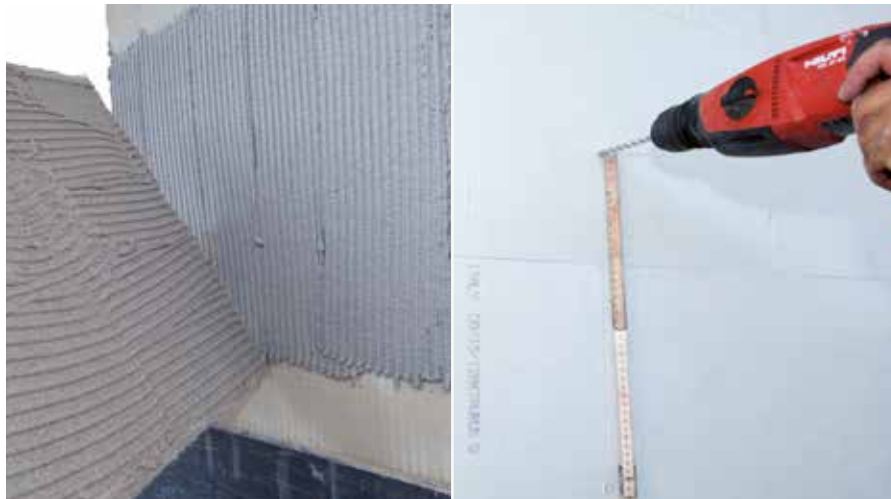
Sučelno postavljanje ploča u svježi mort bez zapunjavanja fuge
