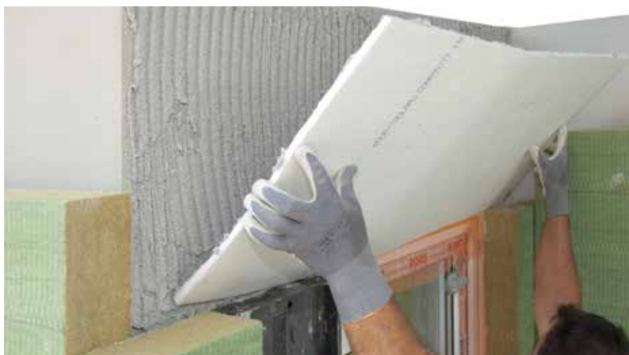
RÖFIX Aerogel izolacijska ploča lijepi se postupkom „Floating buttering“ (i površina i poledina ploče)
