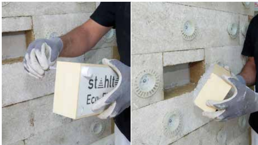
Uklanjanje EPS čepova
