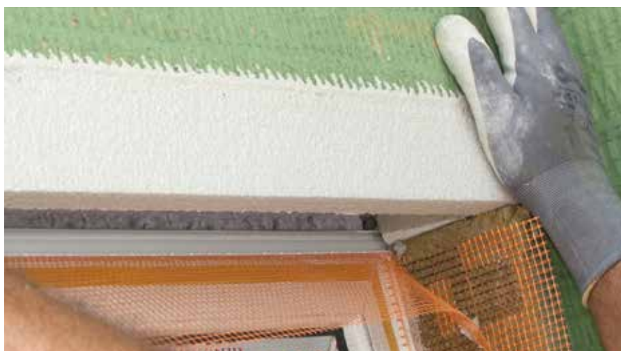
Obložni element lijepi se punoplošno na površinu i mehanički pričvršćuje s lijeve i desne strane
