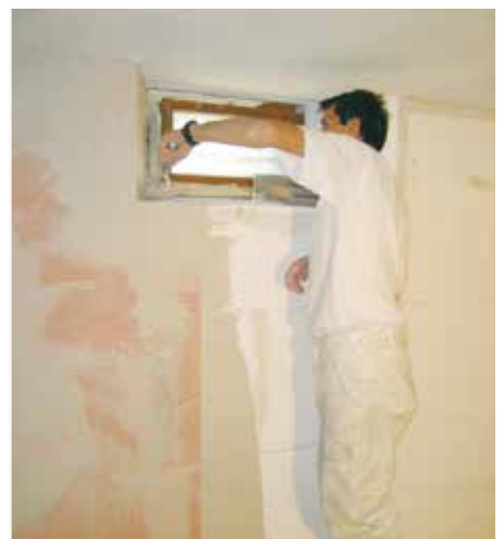
Postavljanje RÖFIX Renopor® Rubne prenosnice
