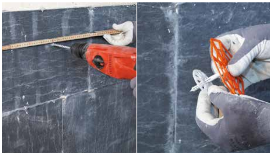
Pričvršnice postaviti u rasteru 40x40 i montirati prema uputama na pakiranju
