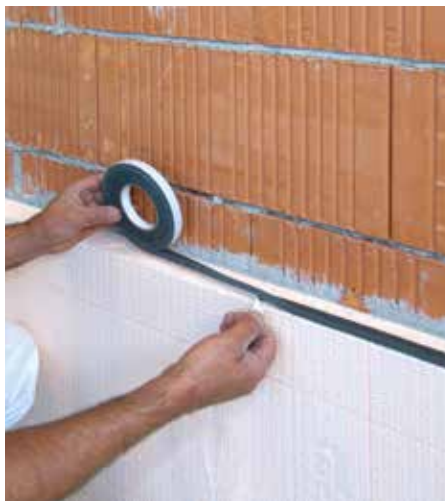
Lijepljenje izolacijske trake za fuge na ploču
