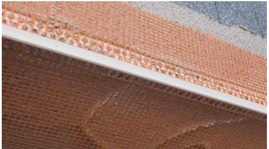
Okapni profil se polaže u svježi mort za lijepljenje i armiranje
