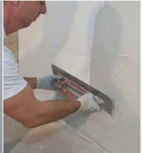
Armiranje RÖFIX Renopor® specijalnim ljepilom
