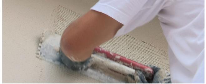
Für Nachbesserungsarbeiten wird 10 % Fixit 497 Putz- und Mörtel­emulsion ins Anmachwasser für den Fixit 222 zugegeben. Dies verbessert die Haftung auf dem Untergrund und vereinfacht die Handhabung. Besonders kritische Stellen werden direkt mit Fixit 497 Putz- und Mörtel­emulsion bestrichen.
