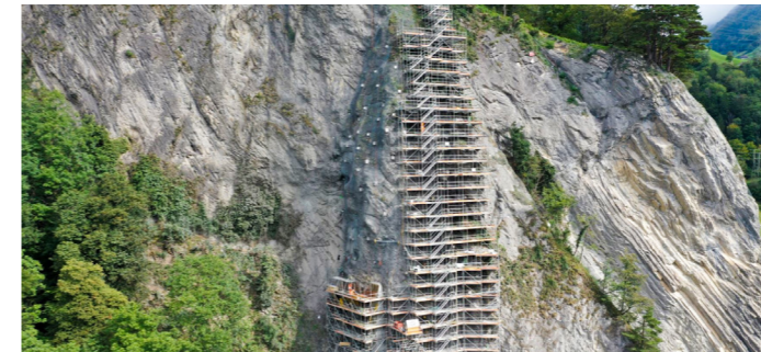
Felssicherung Axenstrasse, Sisikon UR
