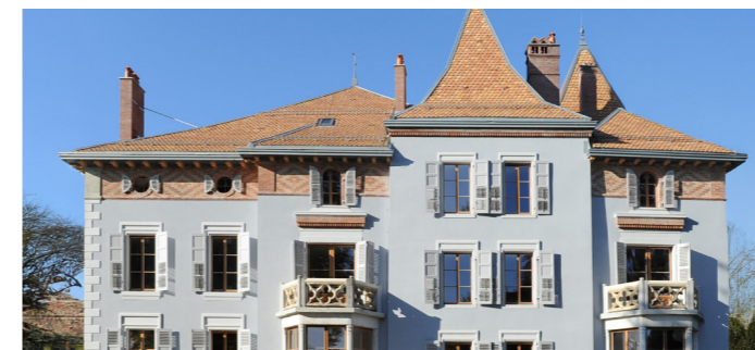
Wärmedämmputz Villa, Morges VD
