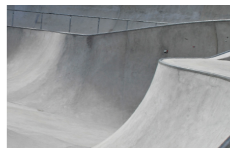
Beton- und Tiefbau
