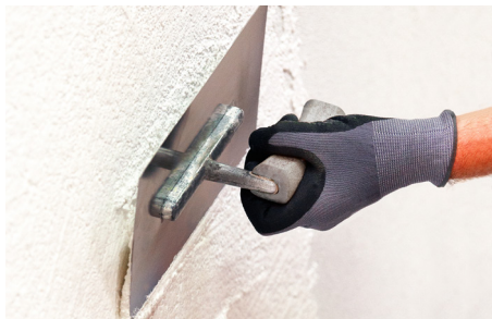
Ober- und Deckputze
