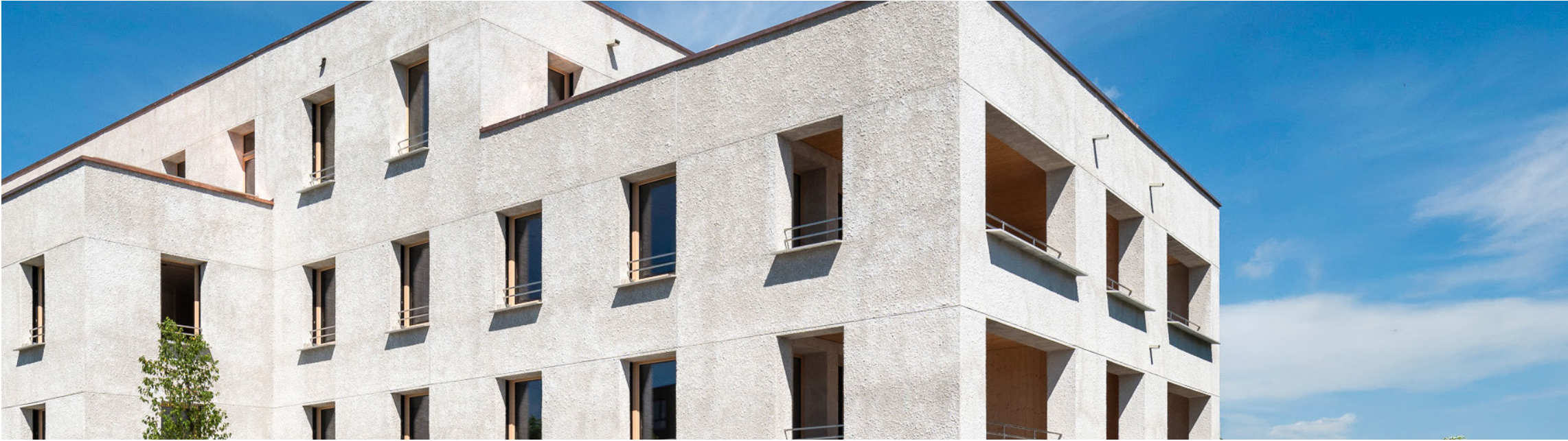
Nachhaltige und klimaneutrale Bauweise
