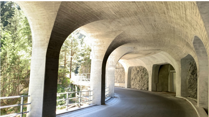
Instandsetzung "Galerie Viamala 1", Schweiz
