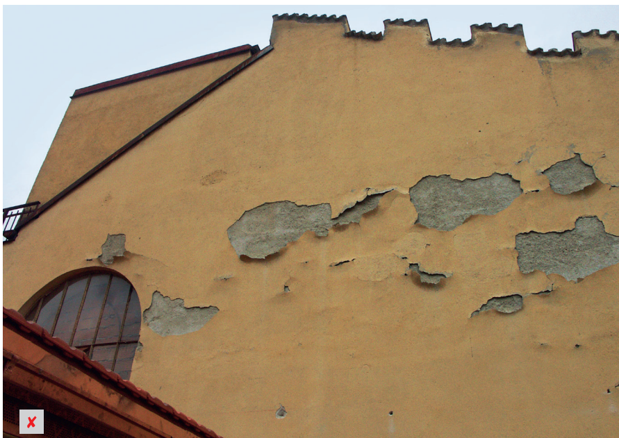
Rezultatele renovărilor cu mase de șpaclu prea dense sau prea rigide
