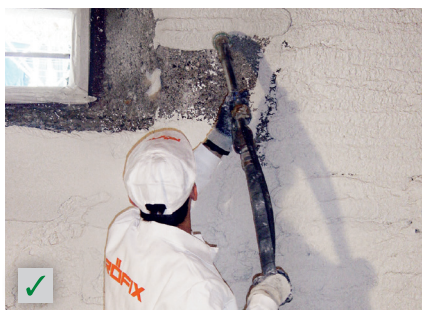
Egalizarea suportului înainte de aplicarea stratului final (culori noi, tencuieli de finisare) RÖFIX Renoplus®
