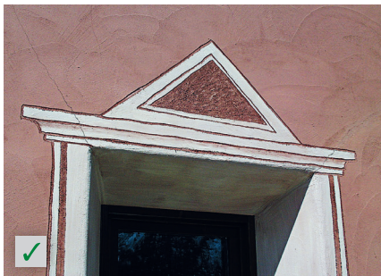
Fisuri în tencuială RÖFIX Renostar®, RÖFIX Renoplus®
