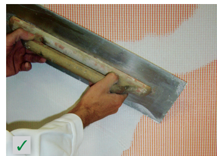
Strat de armare în cazul suporturilor problematice RÖFIX Renostar®, RÖFIX Renoplus®
