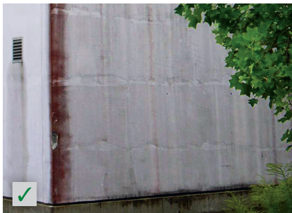
Infestare cu alge RÖFIX Renostar®, RÖFIX Renofino®
