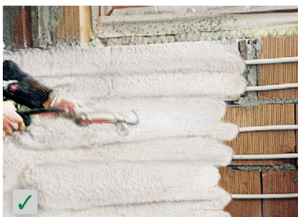
Încorporarea în tencuială a încălzirii în perete RÖFIX Renoplus®
