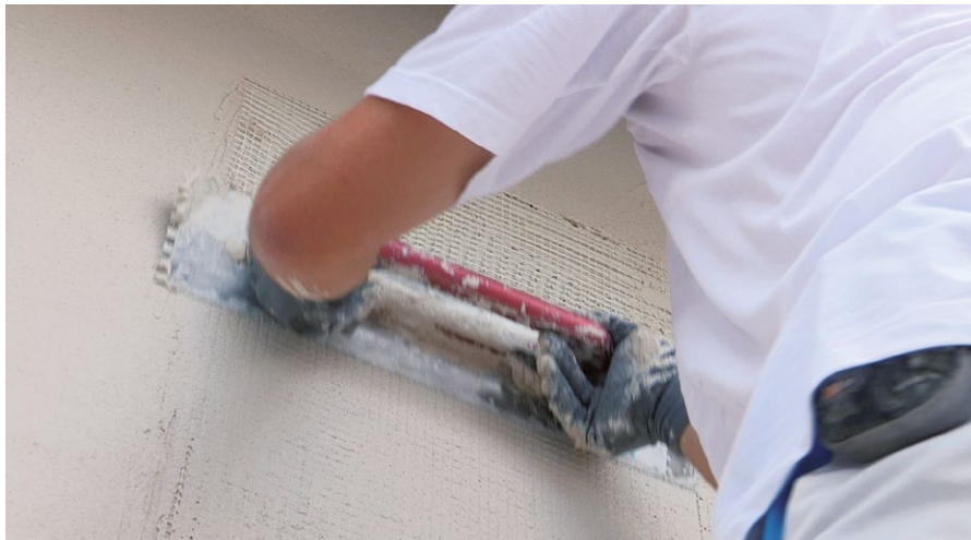
Gewebeeinbettung mit Armiermörtel
