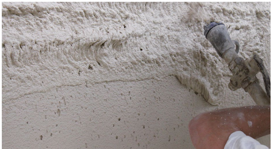
Putzapplikation mit handelsüblicher Putzmaschine
