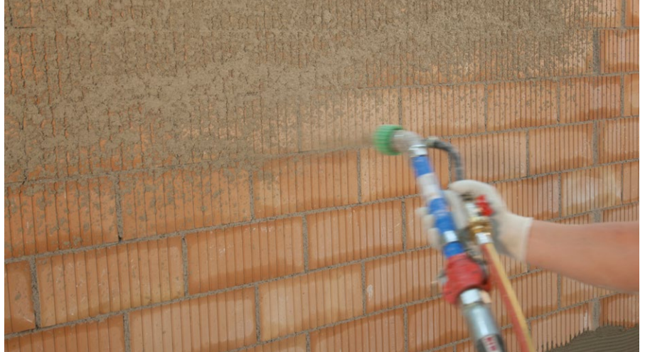
Untergrundvorbehandlung mit handelsüblicher Putzmaschine
