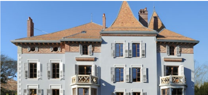
Теплоізоляційна штукатурка на віллі у Моржі, Швейцарія
