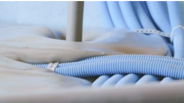
Оптимальне вирівнювання поверхні
