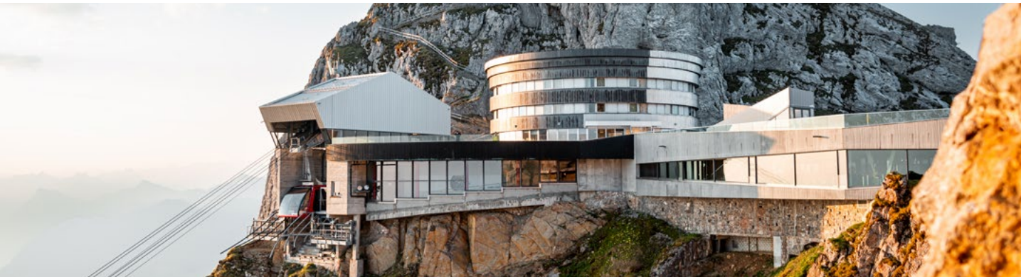
Розширення зали очікування станції «Pilatus Kulm mountain station», Швейцарія
