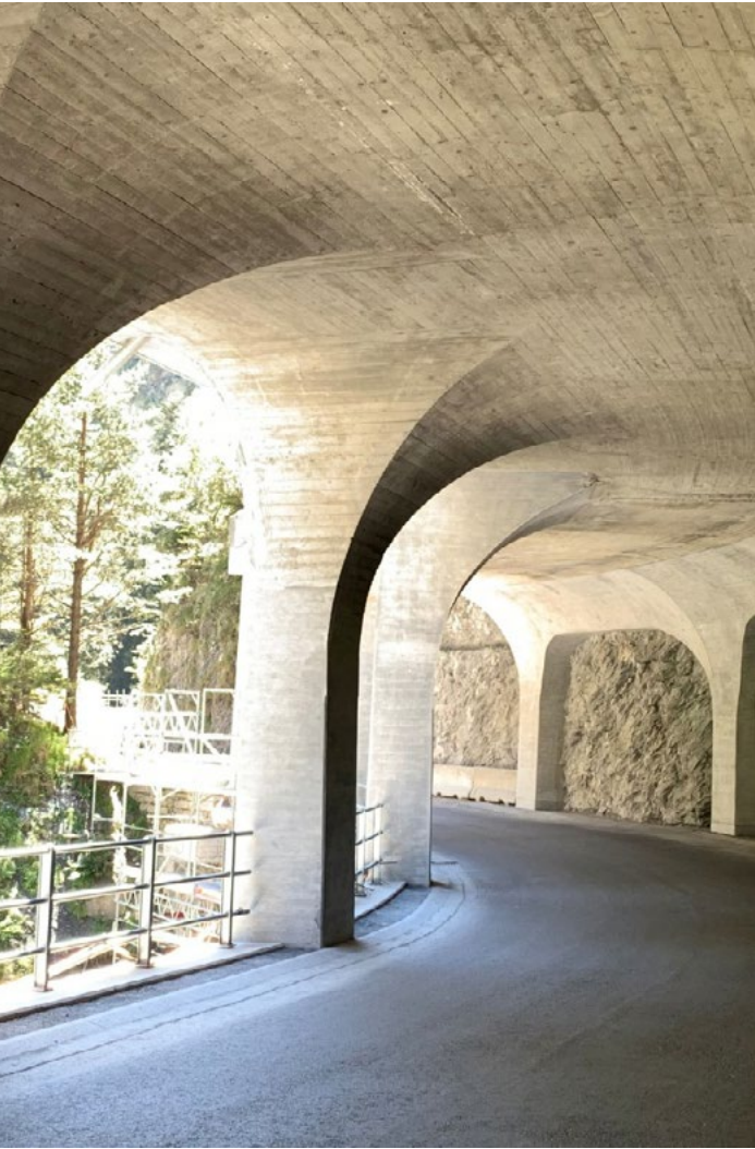
Реконструкція галереї «Viamala 1 gallery», Швейцарія
