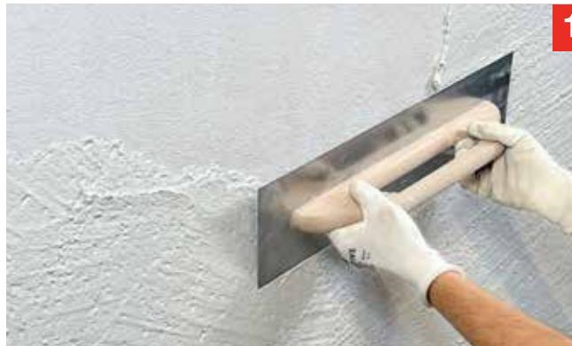
1. Auf die Armierungsschicht wird als Rillen-Deckputz der Greutol Silikonharz Deckputz 360 aussen Rillenstruktur in Kornstärke aufgezogen.
