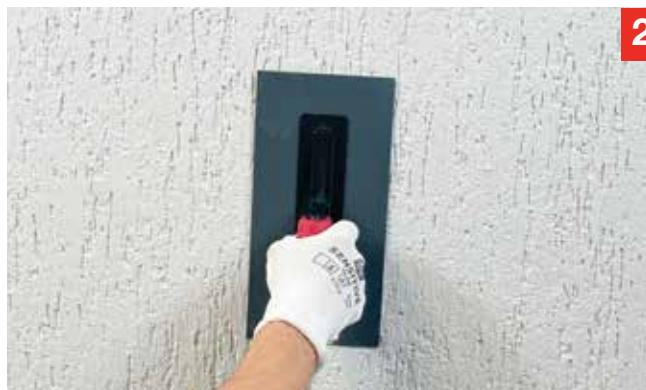
2. Der noch frische Greutol Silikonharz Deckputz 360 aussen Rillenstruktur wird gleichmässig in vertikaler Richtung mit der Kunststoff-Reibscheibe strukturiert.
