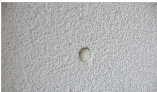
Deckputz anmischen und einige Minuten anziehen lassen. Bei der Auffüllung des Gerüstlochs sollte der Putz eine gewisse Steifigkeit aufweisen, um das anschließende Modellieren zu vereinfachen.
