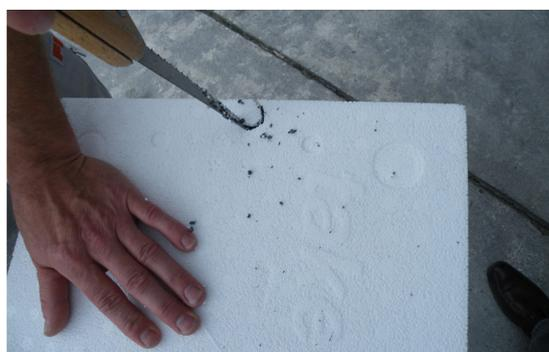
Mit Stichsäge auf Gerüstloch angepassten Pfropfen aussägen und kontrollieren, ob die Grösse stimmt. Tendenziell sollte der Pfropfen eher zu gross geformt sein.
