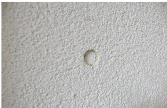
Deckputz anmischen und einige Minuten anziehen lassen. Bei der Auffüllung des Gerüstlochs sollte der Putz eine gewisse Steifigkeit aufweisen, um das anschließende Modellieren zu vereinfachen.
