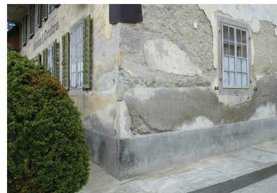
Efflorescenze sopra l'intonaco a base cemento
