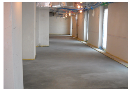
Il rivestimento viene bocciardato Applicazione dell'intonaco di risanamento Murature del piano seminterrato dopo l'applicazione dell'intonaco di risanamento
