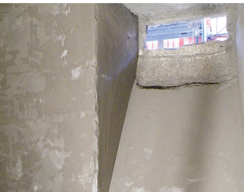
Impermeabilizzazione interna di muri perimetrali con intonaco impermeabile.
