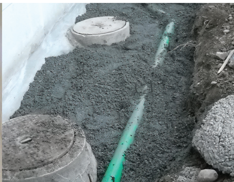
Impermeabilizzazione esterna con drenaggio
