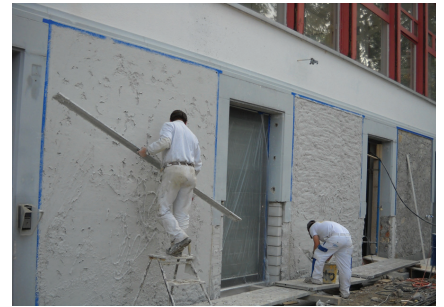
L'applicazione di intonaco di risanamento
