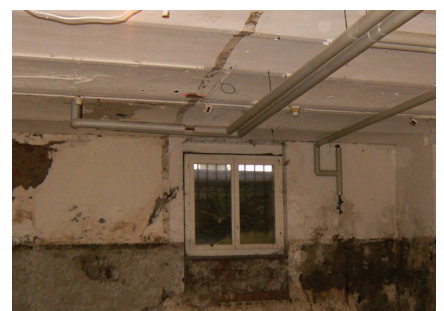
Murature del piano seminterrato dopo le inondazioni
