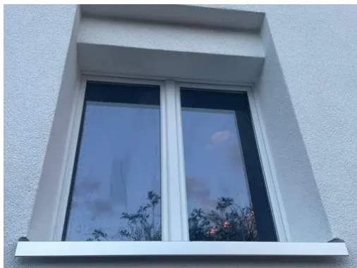
Fenster nach den Arbeiten
