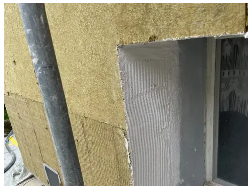
Realisierung von Fenster- und Türrahmen
