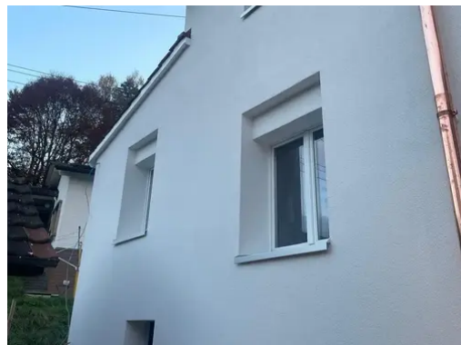
Fassade nach den Arbeiten
