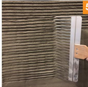
**5.** Après durcissement de la 1<sup>ère</sup> couche d'enduit de fond, gratter avec un peigne. Le temps de repos pour les enduits de fond au ciment calcaire et les enduits au plâtre est d'un 1 mm par jour.
