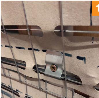
**1.** Fixation avec SBS et vis à bois 45 mm
