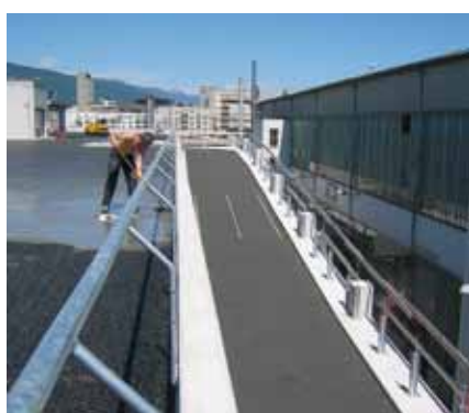
Aree di parcheggio per autovetture e automezzi pesanti
