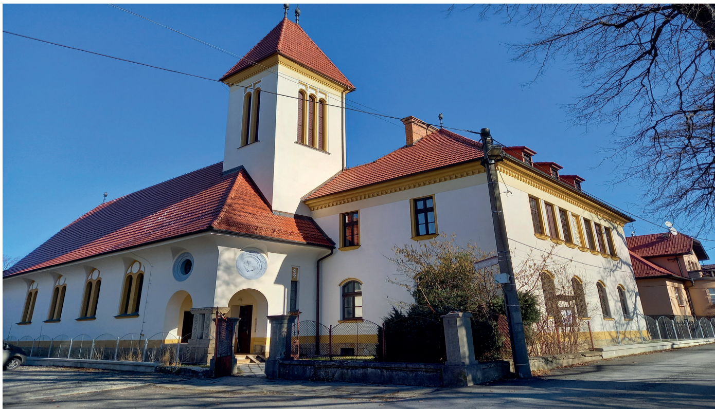
Sanace a renovace
