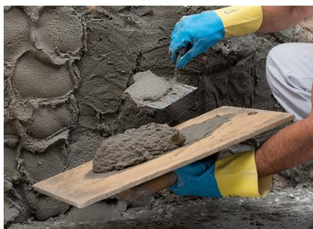
6<sup>e</sup> Projeter l'enduit de fond sur les supports prémouillés en couches de 20 mm en travaillant rapidement.
