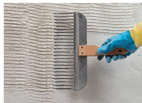
5<sup>o</sup> Travailler l'enduit de fond en couche de 20 mm.
