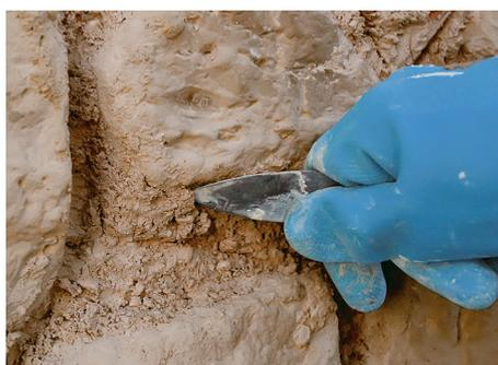
1<sup>er</sup> Retirer l'enduit attaqué par le sel jusqu'à 1 m au-dessus de la limite du dégât jusqu'à atteindre la maçonnerie.
