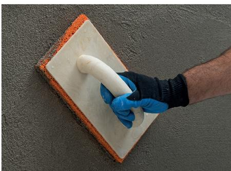
7<sup>e</sup> Appliquer une épaisseur totale d'enduit d'au moins 20 mm.
