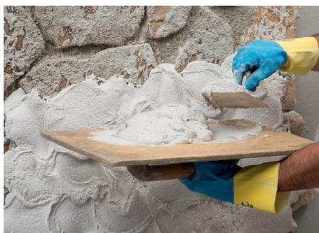
6<sup>o</sup> Appliquer une épaisseur totale d'enduit de 40 mm maximum.
