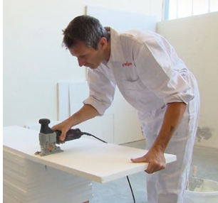
2 Preparazione dei pannelli
