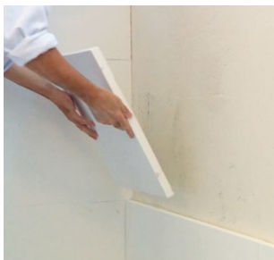
4 Applicazione dei pannelli isolanti
