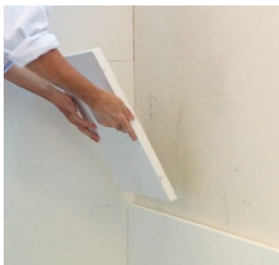
4 Applicazione dei pannelli isolanti
