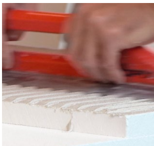
3 Incollaggio dei pannelli isolanti
