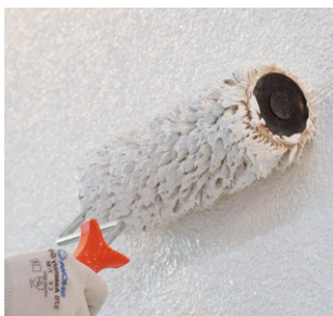
7 Pitturazione con pitture altamente permeabili al vapore
