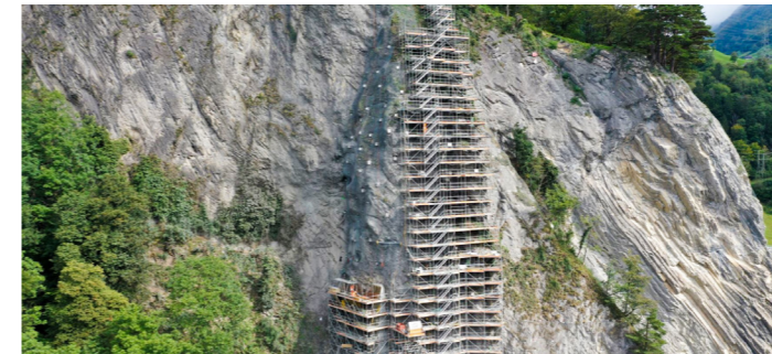
Rock stabilisation Axenstrasse, Sisikon UR
