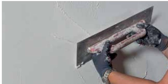
Le Fixit 764 Crépi à la truelle peut être projeté manuellement, indépendamment de la granulométrie, sur la colle et mortier d'enrobage fraîchement appliqué...
