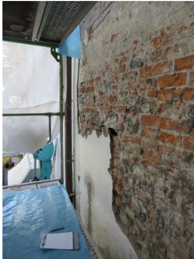
Bild 11: Westfassade, Feld A2 nach Abnahme des hohlliegenden Bestandputzes.
