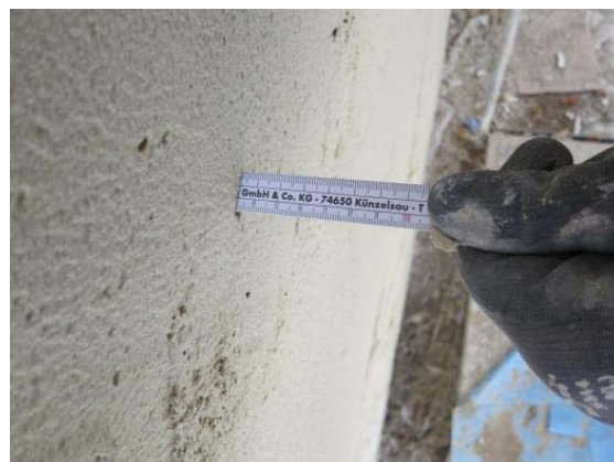
Bild 21: Schichtdicke Feld A2 (Erdgeschoss, Wärmedämmputz F244)
