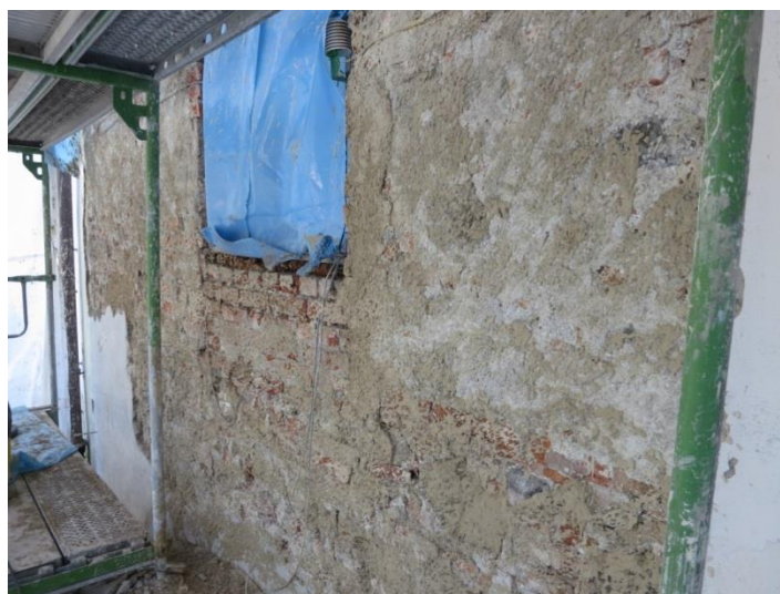
Bild 15: Auftrag eines halbdeckenden Anwurfs als Vorbereitung für die Applikation des Dämmputzes.
