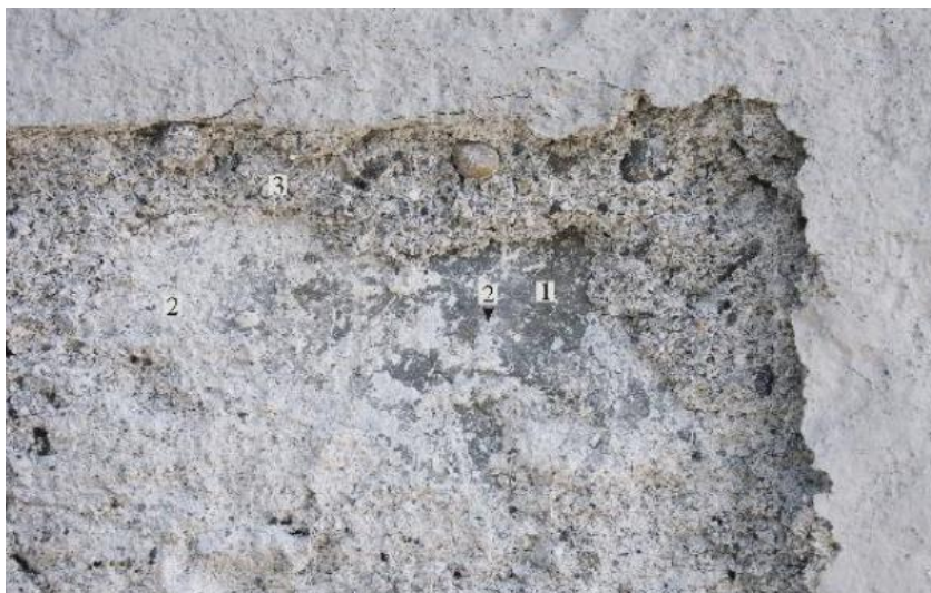
Bild 5: Putzuntersuchung Nordbau Westfassade: 1. Naturstein, 2. Schlämplputz, 3. Weicher heller Kalkputz; Auszug Untersuchung Stein 2010 [1].
