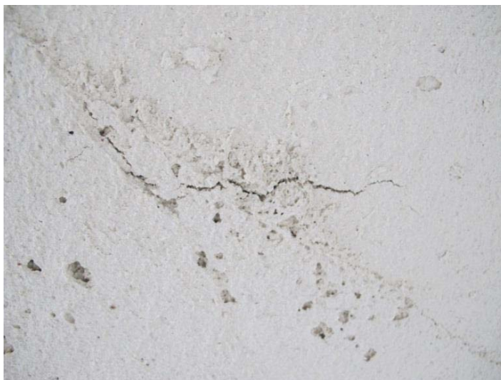
Bild 24: Kleinere Schwundrisse im Bereich des Feldes A2.
