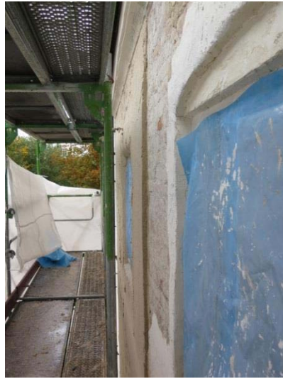
Bild 25: Anschluss an die bestehende Gesimskante im oberen Bereich des Messfeldes A1.
