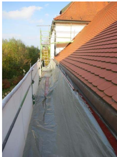
Bild 27: Schützende Plane an der obersten Gerüstlage.
