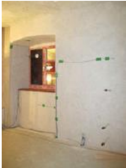
Bild 8: Innenraum des Messraums 1 mit Innendämmputz (demontiert am 26.7.2016).
