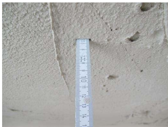
Bild 20: Schichtdicke Feld A1 (Obergeschoss, Wärmedämmputz F222).
