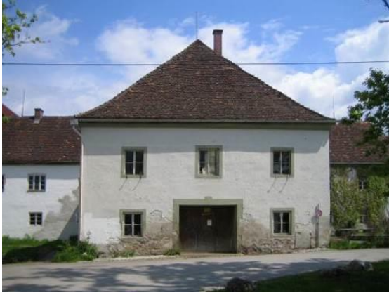
Bild 1: Alte Schöfflerei, Westfassade des Nord- und Kopfbaus. Vorzustand 2010.
