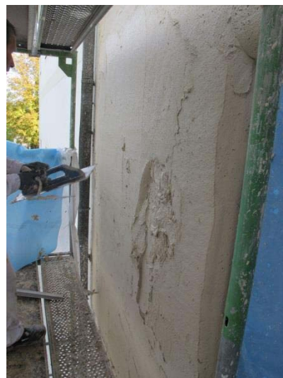
Bild 23: Glätten des aufgespritzten Materials, ohne eine neubauartig glatte Oberfläche zu schaffen.
