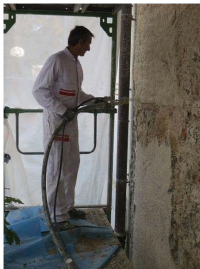
Bild 18: Schichtweise Applikation des Aerogel Dämmputzes mittels Spritzmaschine.
