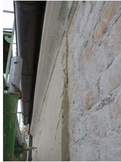
Bild 26: Detailaufnahme des Anschlusses an die bestehende Gesimskante im oberen Bereich des Messfeldes A1.
