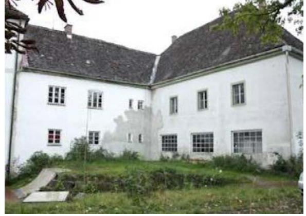
Bild 2: Alte Schöfflerei, Nordfassade des Kopfbaus und Westfassade des Nordbaus. Vorzustand 2010.
