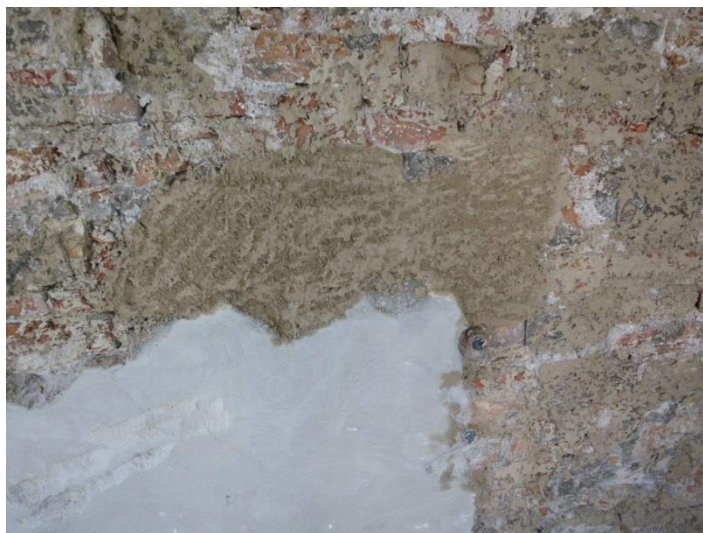
Bild 14: Ausbesserung und Schließung des Lochs in der Fassade (Feld A2).
