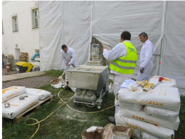
Bild 17: Vorbereitung und Herstellen des Putzmaterials vor Ort in Benediktbeuern.
