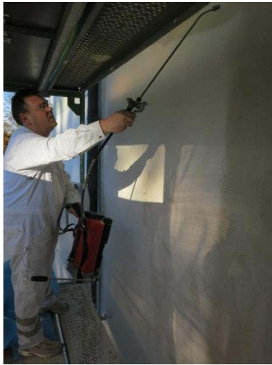
Bild 28: Besprühen der Messfelder A1 und A2 mit dem mineralischen Untergrundstabilisator FIXIT 493.
