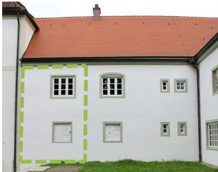
Bild 30: Fertig gestellte Messfelder A1 und A2 der Firma Fixit AG auf der linken Seite der Fassade.
