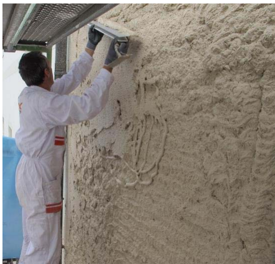
Bild 22: Abziehen und Glätten des aufgespritzten Materials.
