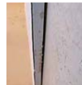
Plattensanierung mit Hohlräumen
