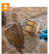
Procéder à un nettoyage humide en profondeur. Lors de l'application, le support doit présenter un aspect mat humide / de terre humide
