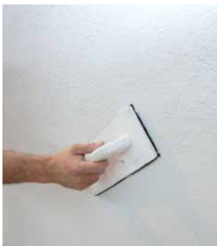
Strukturiranje RÖFIX Renopor® Specijalnim ljepilom
