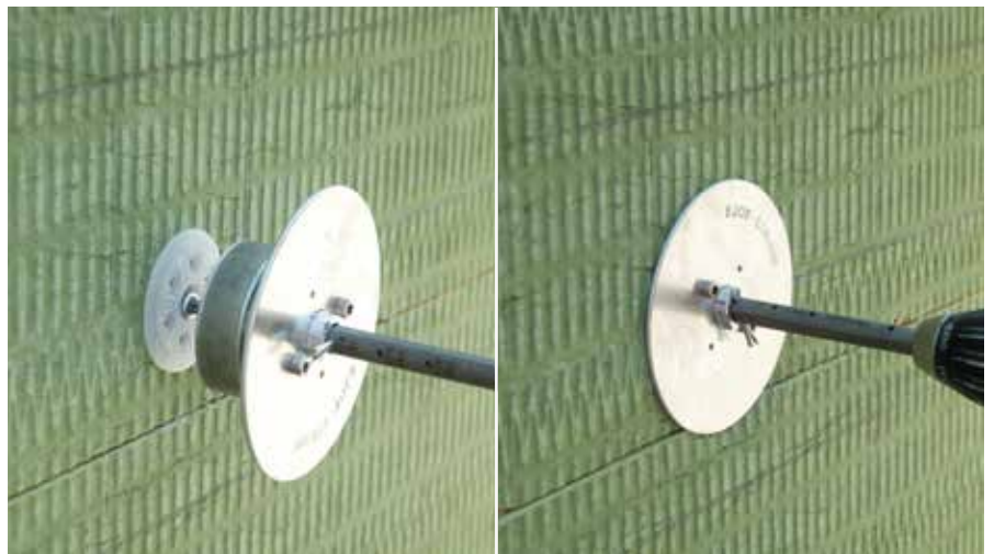
RÖFIX STR-Tool 2G određuje dubinu uvrtnja tiplje
