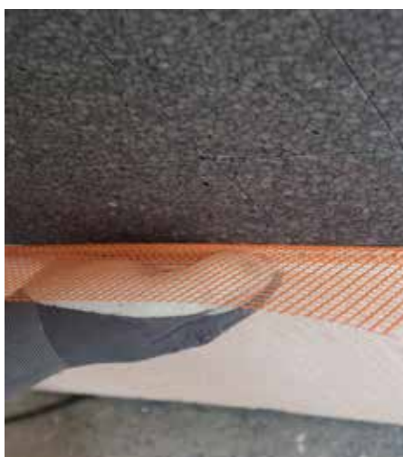
Umetanje RÖFIX spojnog profila za sokl
