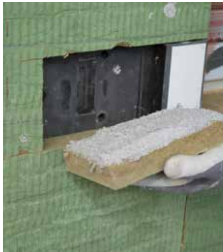
Vijke prelijepiti/prekriti izrezanom izolacionom pločom
