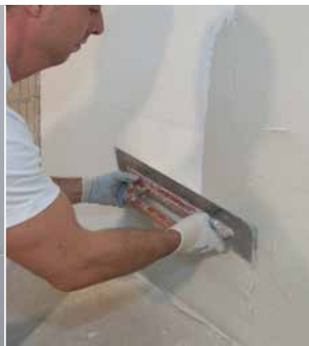
Armiranje RÖFIX Renopor® specijalnim ljepilom
