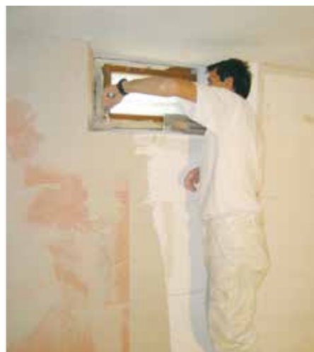
Postavljanje RÖFIX Renopor® Ivične premosnice
