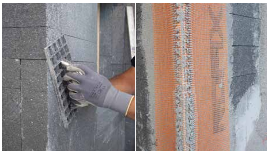
Viškove izolacionih ploča obrusiti
