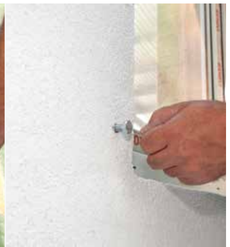
Vijčano pričvršćenje montažnog elementa M-vijkom
