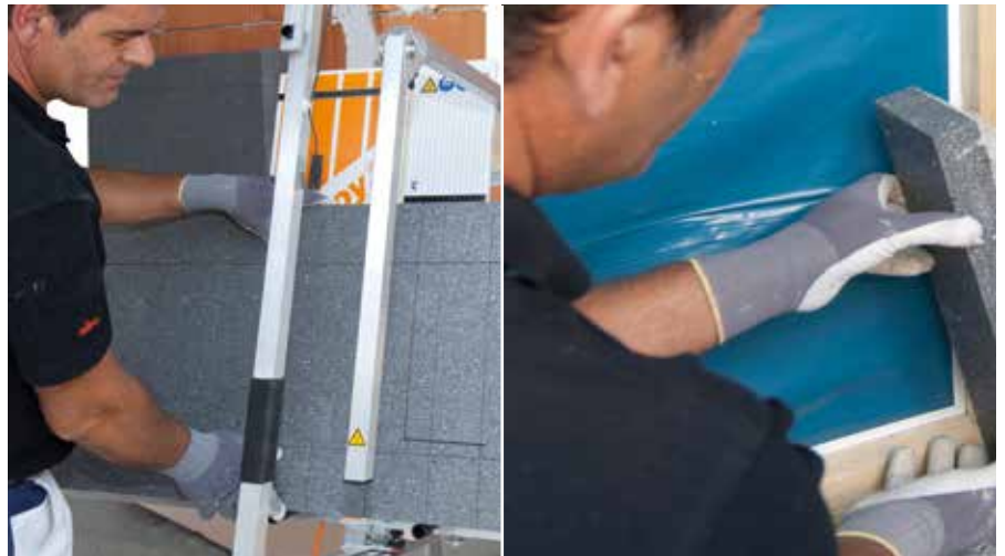
Rezanje ploča RÖFIX Isoboy EX 34-K ugaonim rezačem
