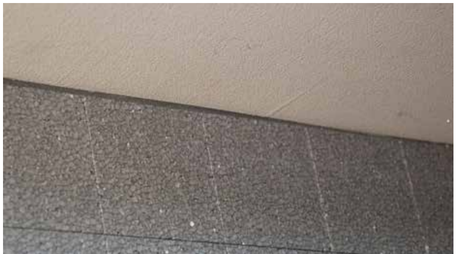
Fasadna izolaciona ploča se kod lijepljenja pritišće uz izolacionu traku za fuge
