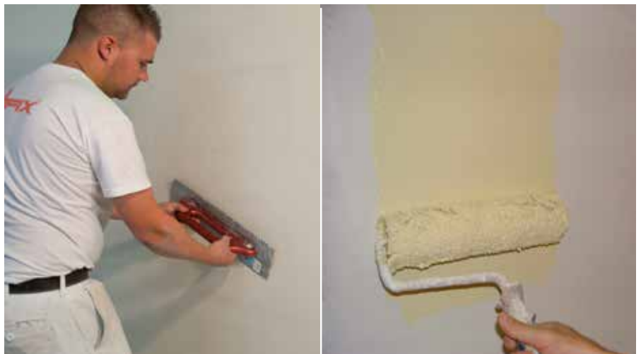
Nanošenje pokrovnog maltera
