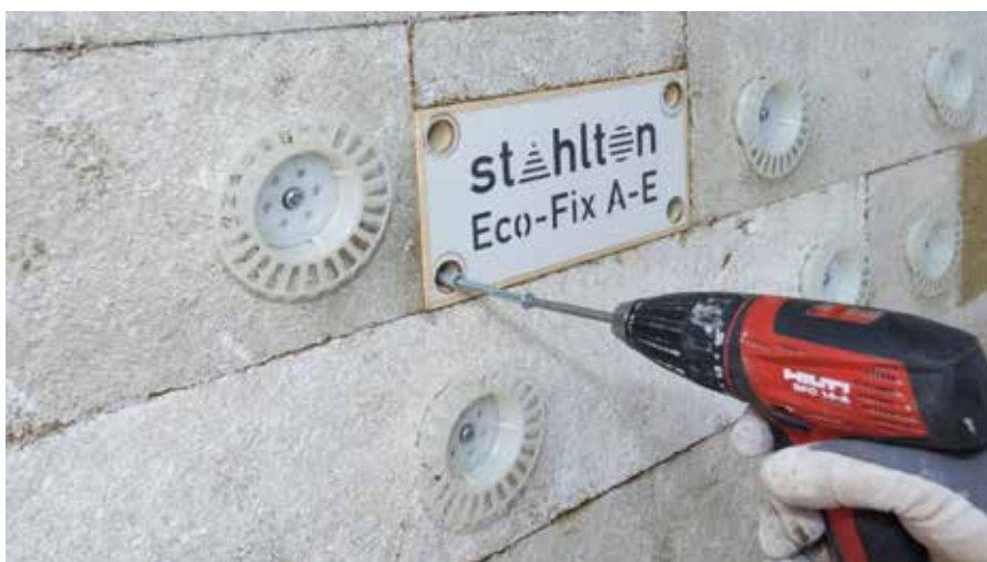
Pričvršćenje elementa
