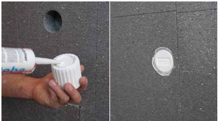
Nanošenje PU-ljepila na kružnu stranu Zyrillo-a i po površini otvora
