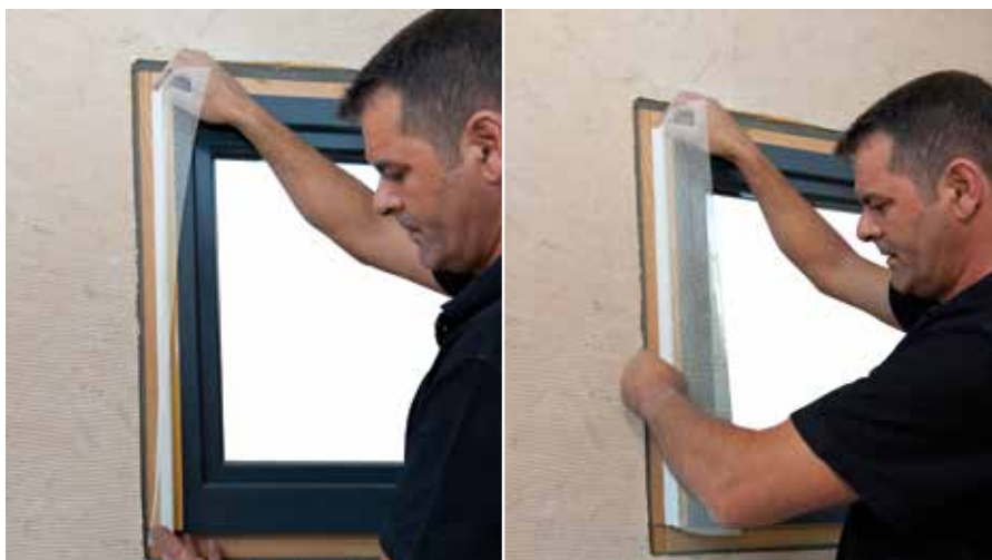
Profil postaviti u desnom uglu na aluminijumskom prozorskom okviru te zalijepiti na donji drveni okvir
