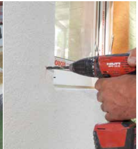
Bušenje rupe odgovarajućim svrdlom
