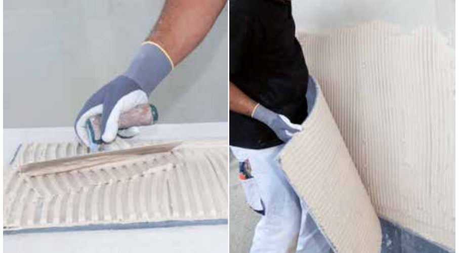
Ljepilo bogato nanijeti na izolacionu ploču i pročešljati, postupak ponoviti na podlozi te potom izolacionu ploču utopiti u podlogu
