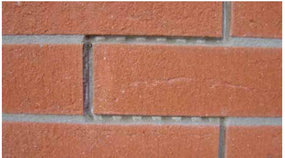
Dilatacione fuge: ljepilo i masu za fugiranje izdubiti do armirajućeg sloja, potom grundirati sa Sika- Primer 3N i zapuniti elastičnim fasadnim kitom Sikaflex Pro2HP
