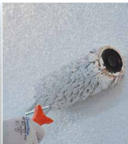
Premaz paropropusnim bojama
