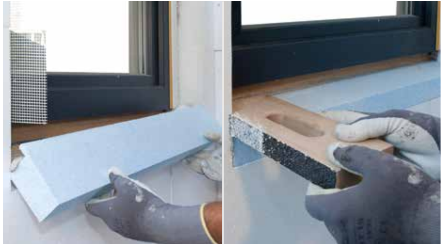
RÖFIX SOL-PAD Base zalijepiti i izdubiti udubinu radi postavljanja priključnog profila za prozorsku klupicu
