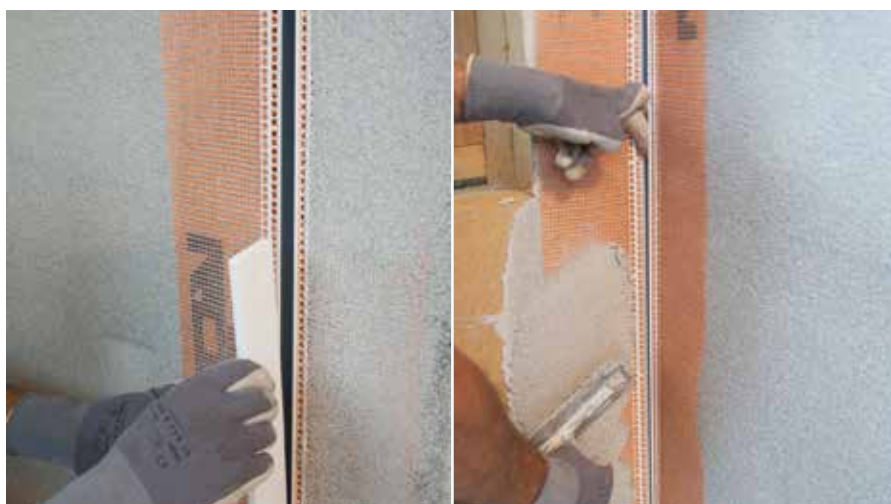
RÖFIX Profil dilatacione fuge E-forme
