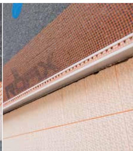
Izgled završenog, nepropusnog spojnog profila za sokl s ugrađenim okapnim profilom prije malterisanja
