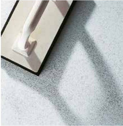
Fini malter – spužvasti gleter/gleter od spužvaste gume
