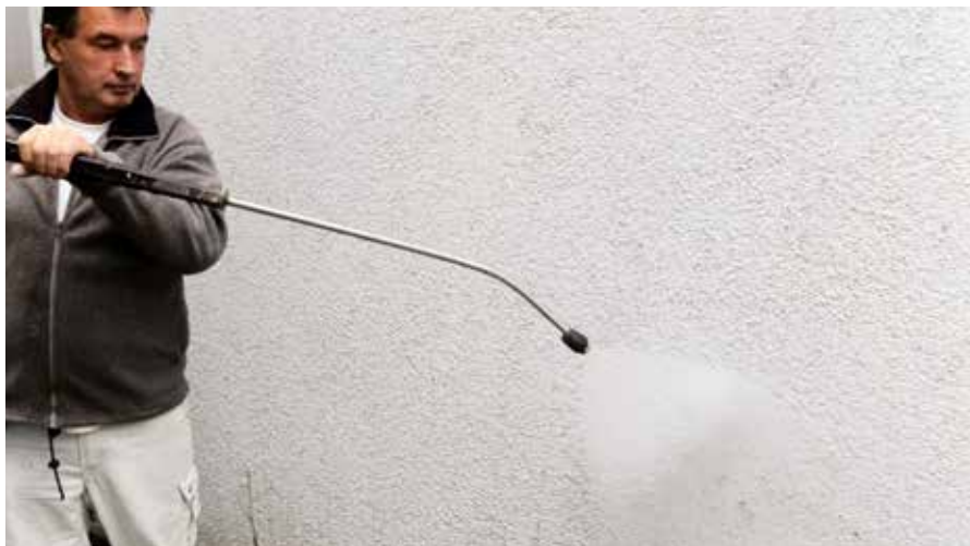
Fasadu oprati, a ostatke vode propisno ukloniti
