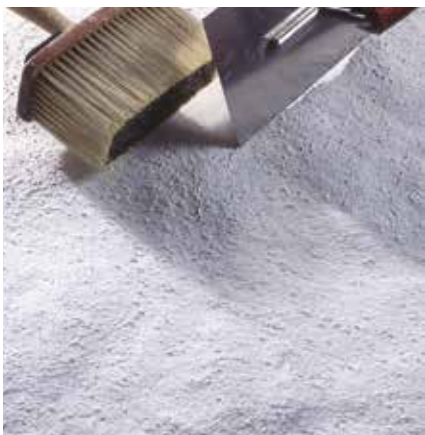
Malter za modeliranje-/Rijetki rustikalni malter – soboslikarska četka
