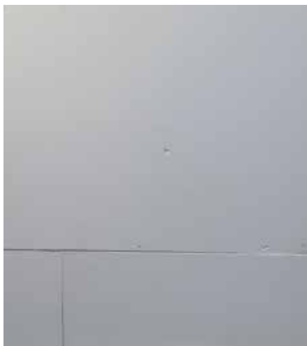
Sučelno spajanje fuga
