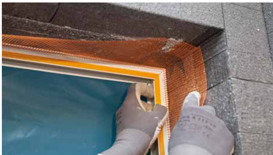
RÖFIX Profilne makaze PRO omogućuju precizno sastavljanje u uglovima prozora
