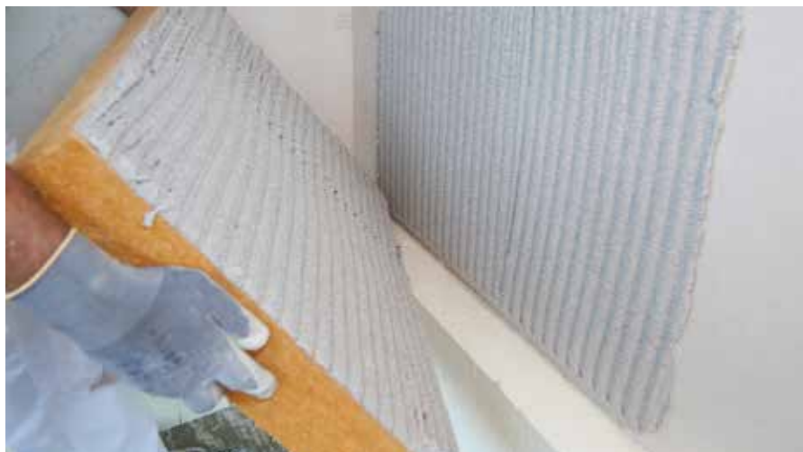
Postavljanje izolacionih ploča sistemom „svježe u svježe“
