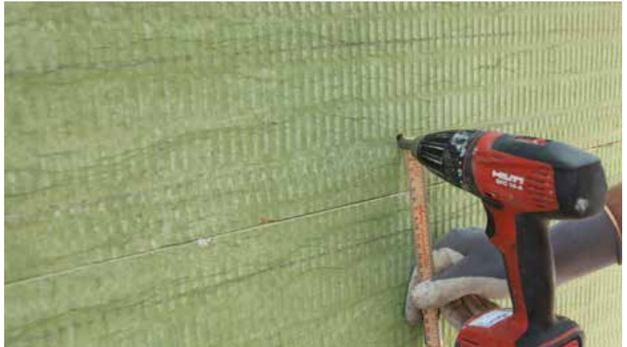
Pričvršćenje izolacione ploče od mineralne vune započinje 5 cm od ivice ploče
