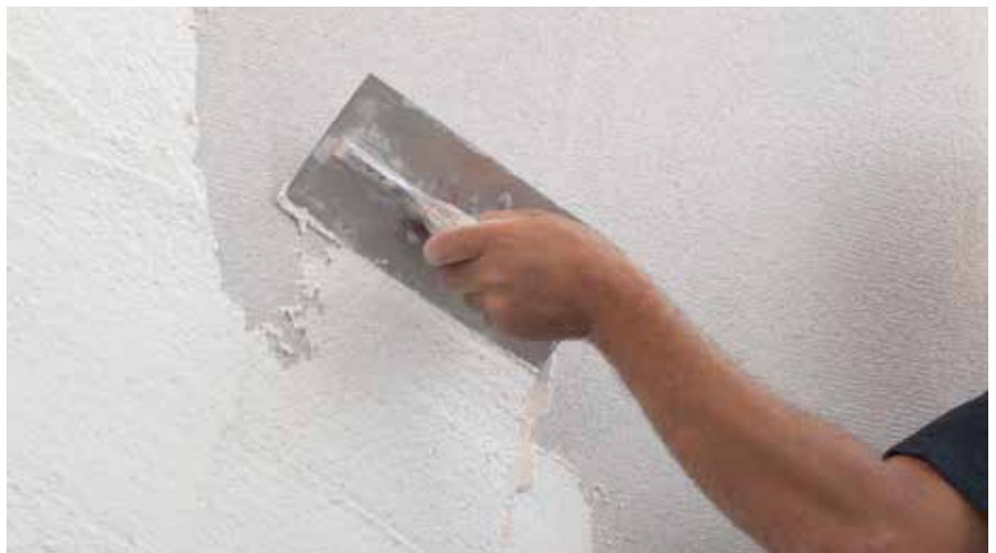
Nanošenje završnog maltera
