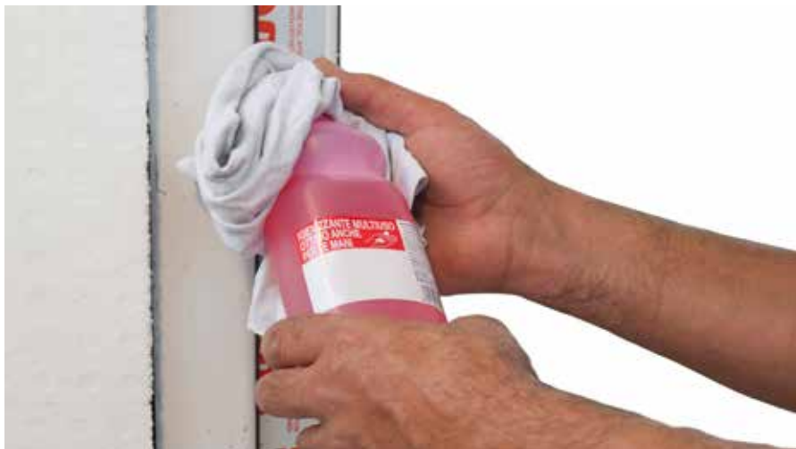
Prozorske okvire temeljito očistiti
