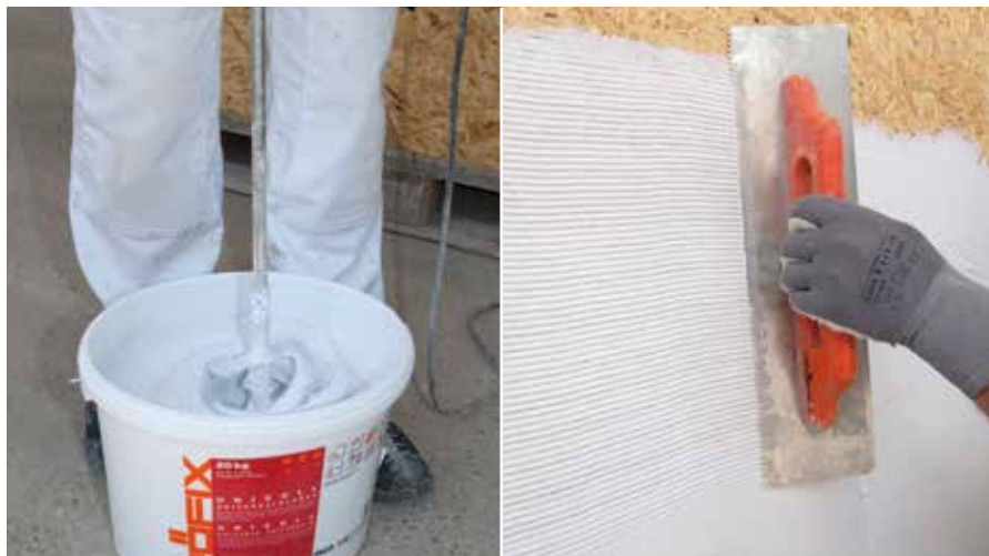
RÖFIX UNICOLL nanosi se tankoslojno i punoplošno i češlja gleterom. Ostaviti da se dobro osuši
