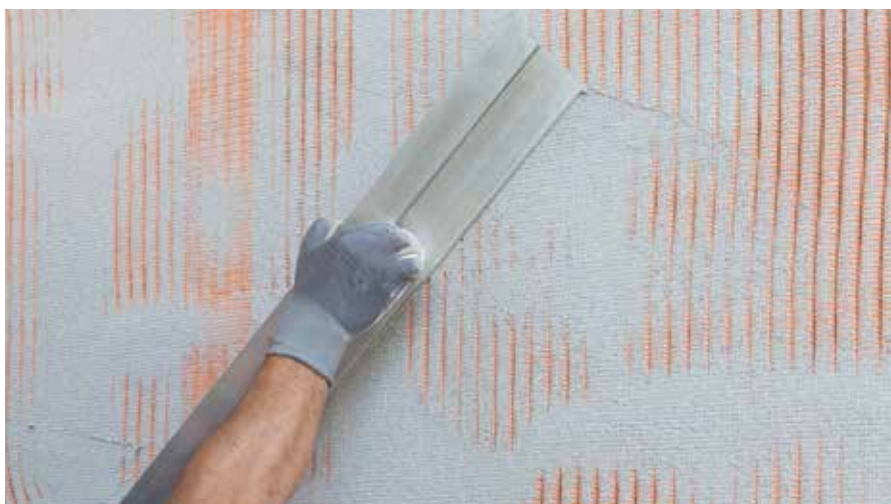
Umetanje RÖFIX P50 Staklene mrežice u svježe pročešljanu masu
