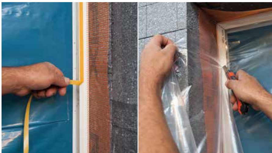
Uklanjanje žute trake sa samoljepljive trake i lijepljenje najlonske folije preko prozora
