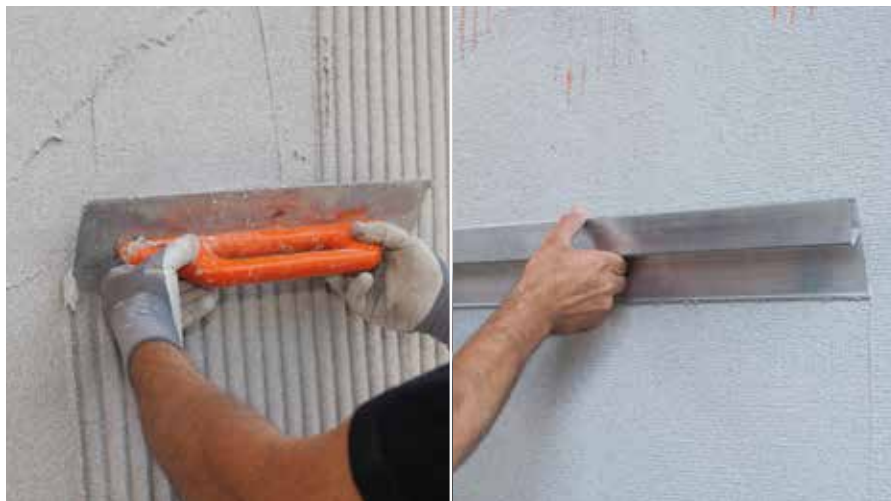
Nanošenje mase zupčastim gleterom u ravnim linijama i utiskivanje RÖFIX P50 Staklene mrežice. Izravnavanje površine aluminijumskom letvom
