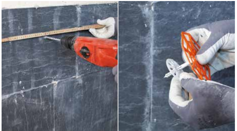
Tiple postaviti u rasteru 40x40 i montirati prema uputama na pakovanju
