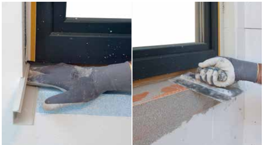
RÖFIX SOL-PAD priključni profil za prozorske klupice zalijepiti RÖFIX POLYMER-om, zatim površinu izolirati s RÖFIX OPTIFLEX® 1K ili 2K
