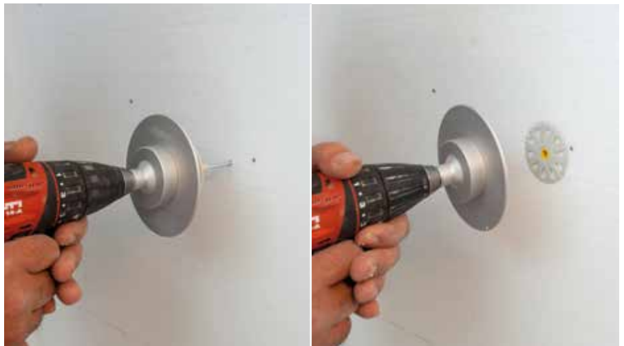
Mogućnost uronjene montaže RÖFIX ROCKET WOOD
