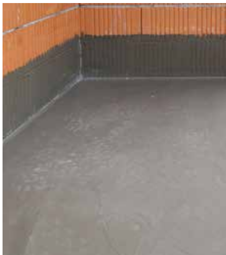
Izolacija sokla i terase RÖFIX Optiseal® -om
