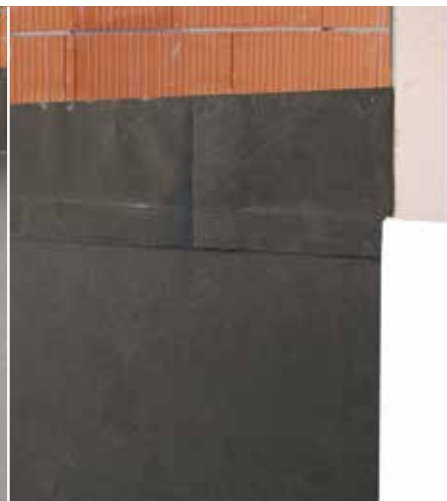
Hidroizolacija sokla bitumenskim trakama
