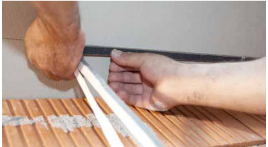
RÖFIX Izolacionu traku za fuge zalijepiti ispod balkona
