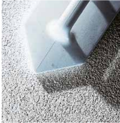
Malter za zaribavanje/malter žljebaste strukture – polistirenska gladilica za zaribavanje
