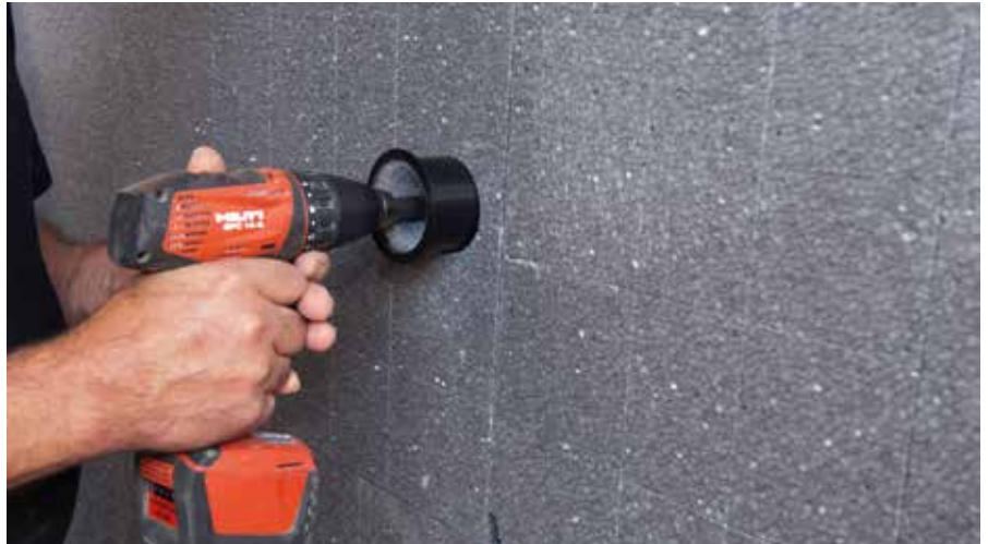
Izvođenje otvora pomoću RÖFIX Zyrillo - alata za glodanje
