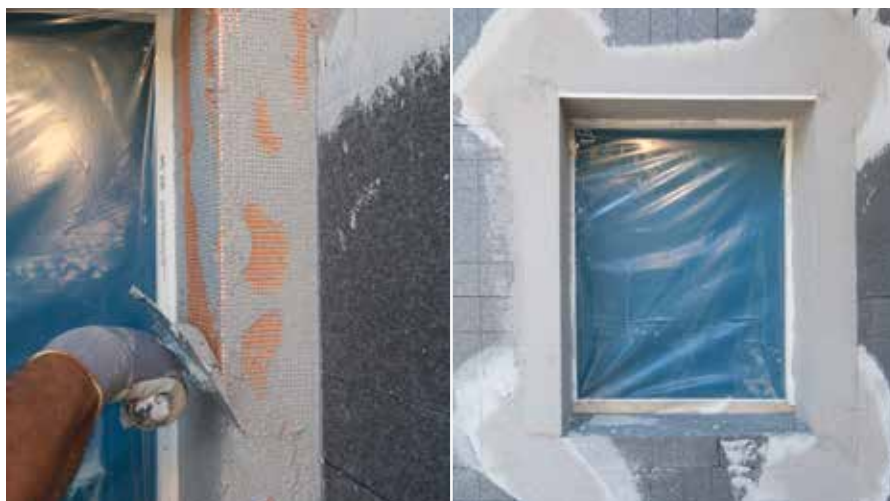
Umetanje ugaonih profila u svježu masu
