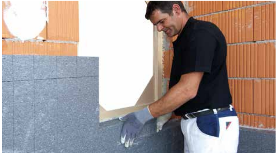
Postavljanje izolacionih ploča oko uglova otvora u obliku slova L
