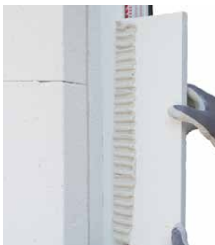
Izbjegavati ostatke ljepila u dodirnim fugama
