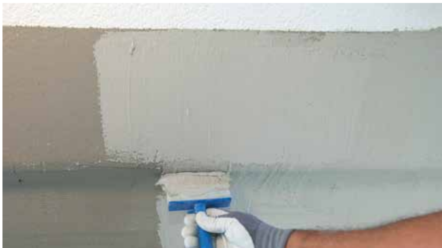
Radi boljeg efekta izolacije drugi izolacioni sloj RÖFIX OPTIFLEX® 1K ili 2K razrijediti vodom
