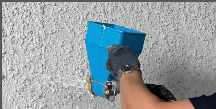
Se aplică tencuiala stop RÖFIX 750 prin intermediul unui aparat
