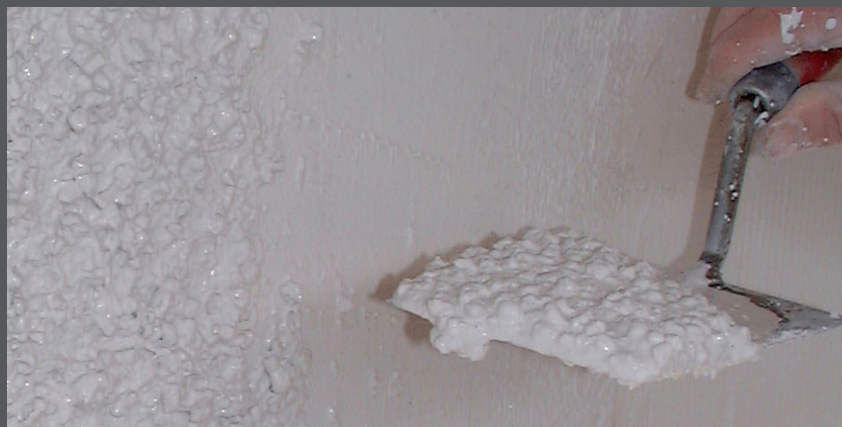
Se aplică manual tencuiala strop RÖFIX 750
