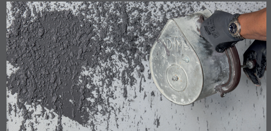
Variantă: Executarea tehnologiei de tencuire prin stropire cu dispozitivul aferent
