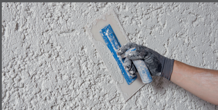
Variantă: Drișcuiți tencuiala strop RÖFIX 750 după aplicare
