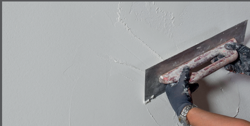
Aplicați Sistem termoizolant cu adezivi de lipire și armare RÖFIX
