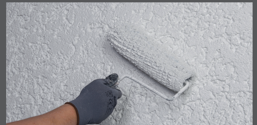
Amorsați tencuiala strop RÖFIX 750 și vopsiți de două ori cu vopsea pentru fațade RÖFIX
