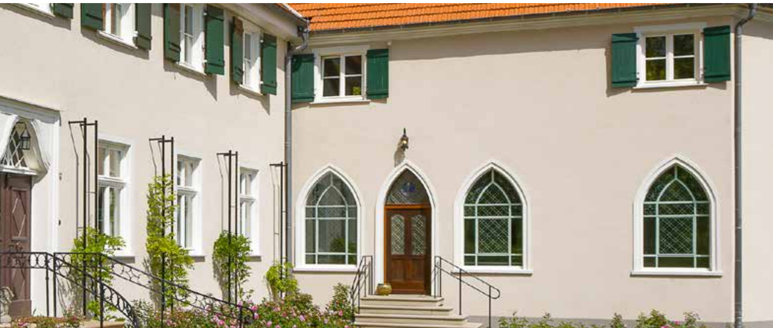
Zabytkowy budynek spotyka się z efektywnością energetyczną
