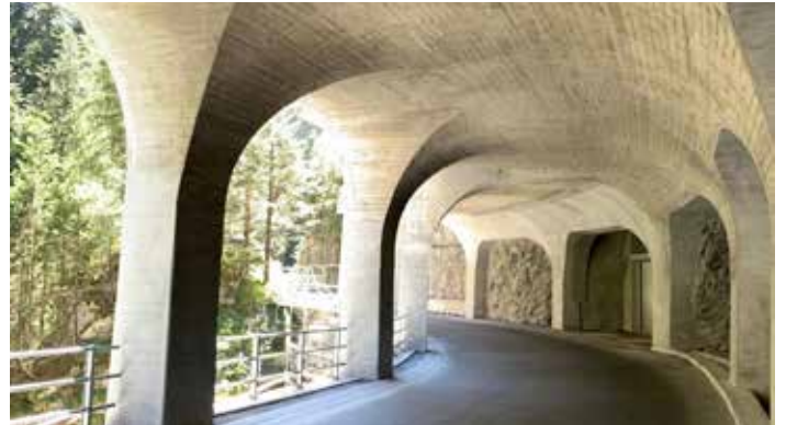
Remont „Galerie Viamala 1”, Szwajcaria
