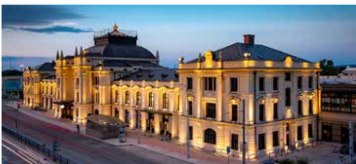
Dworzec kolejowy w Czeskich Budziejowicach, Czechy
