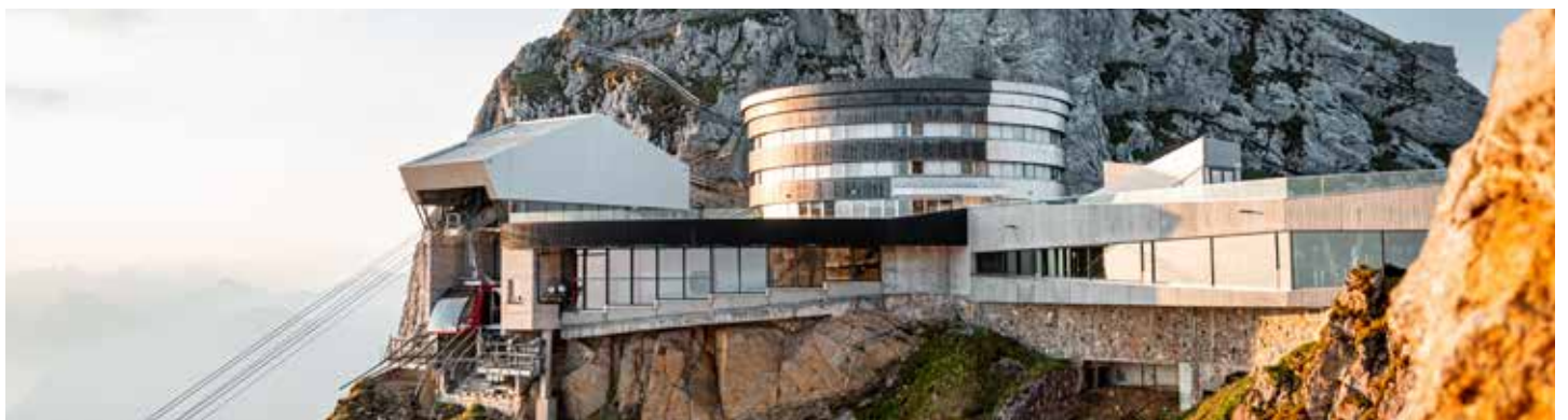
Rozbudowa poczekalni „Bergstation Pilatus Kulm”, Szwajcaria
