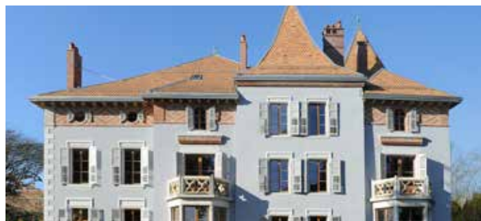
Tynk termoizolacyjny w willi, Morges VD
