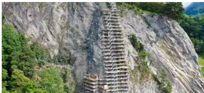
Zabezpieczenie skał Axenstrasse, Sisikon UR
