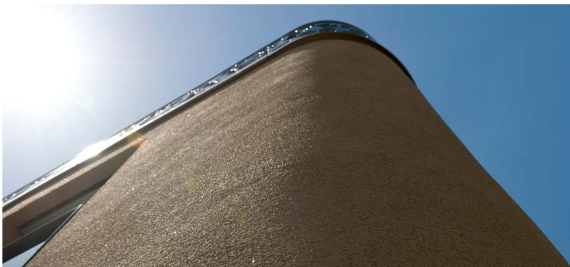
Mehrfamiliengebäude in Zürich Witikon, Objektgrösse 1348 m 2 . Systemaufbau: Dämmung mit Steinwolle, 240 mm, Grundbeschichtung Greutol Einbettmörtel light 425, Netzeinbettung Greutol Multiplanspachtel 407, Deckbeschichtung Greutol Kratzputz light 585.
