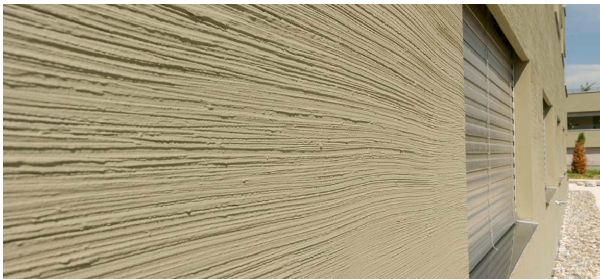
Mehrfamiliengebäude in Reinach, Objektgrösse 1800 m 2 . Systemaufbau: Dämmung mit Steinwolle, 240 mm, Netzeinbettung Greutol Combi-Putz 488, Deckbeschichtung Greutol Silikon Deckputz 365 aussen Vollabrieb, 1.0 und 0.5 mm, Anstrich GreoColor OptiTop.
