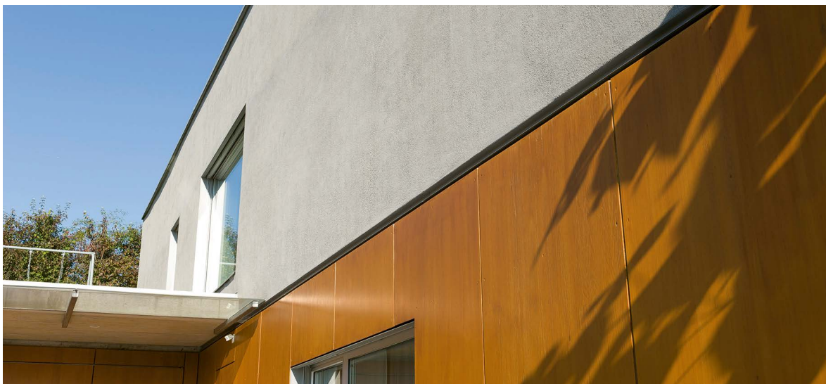
Einfamilienhaus in Zürich Küsnacht, Objektgrösse 370 m 2 . Systemaufbau: Dämmung mit Steinwolle-Lamellenplatten, 160 mm, Grundbeschichtung Greutol Einbettmörtel light 425, Netzeinbettung Greutol Multiplanspachtel 407, Deckbeschichtung Greutol Waschputz 590 light und Silikonharz Deckputz 361, 5 mm.
