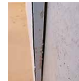
Plattensanierung mit Hohlräumen
