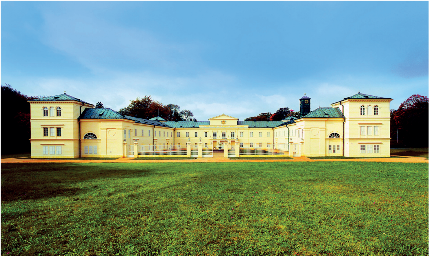
Sanace a renovace
