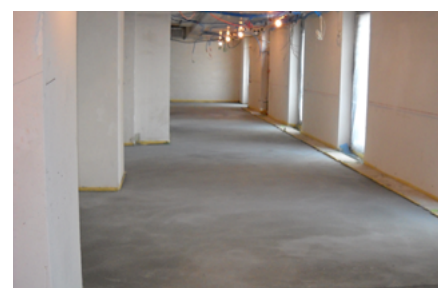
Untergeschoss nach dem Sanierputzauftrag
