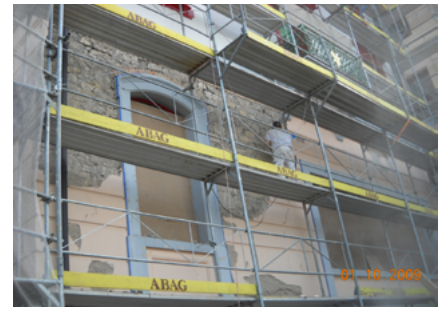
Verputz wird abgespitzt
