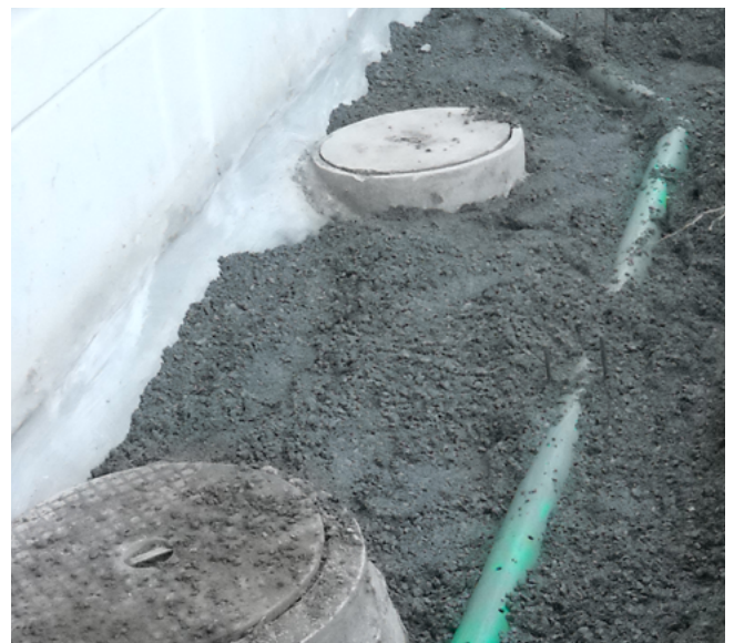
Aussenabdichtung durch eine Sickerleitung
