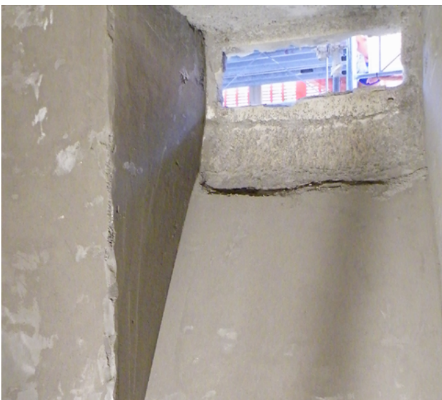
Innenabdichtung der Aussenwand mit Sperrputz
