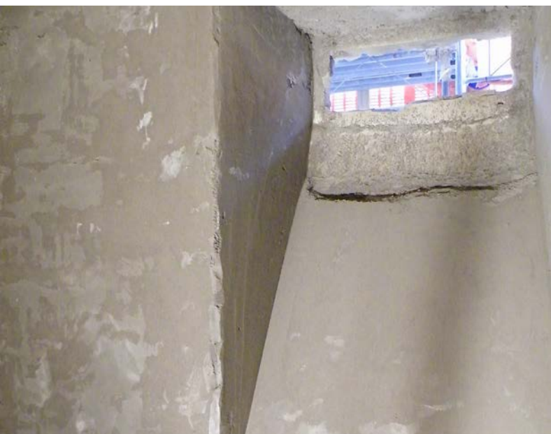
Innenabdichtung der Aussenwand mit Sperrputz
