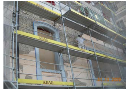
Verputz wird abgespritzt
