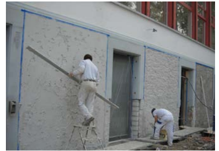
Sanierputz wird aufgetragen
