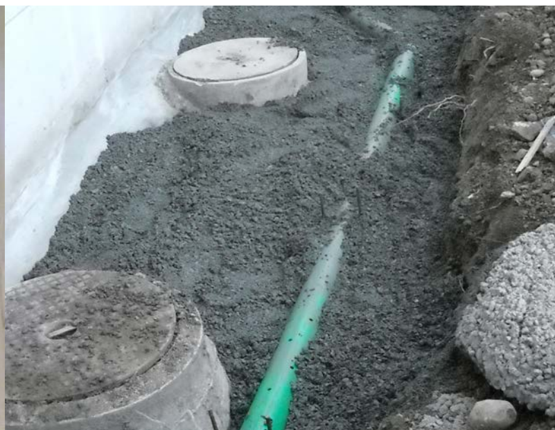
Aussenabdichtung durch eine Sickerleitung
