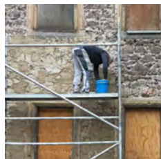
2 Moguće pripreme mjere poput nanosa šprica i(li) nosača žbuke i sl.
