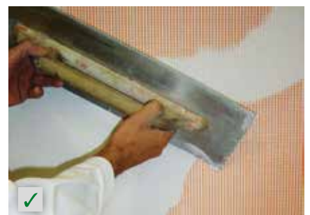
Couche d'armature en cas de supports critiques RÖFIX Renostar®, RÖFIX Renoplus®
