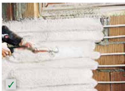
Incorporation du mur chauffant dans l'enduit RÖFIX Renoplus®
