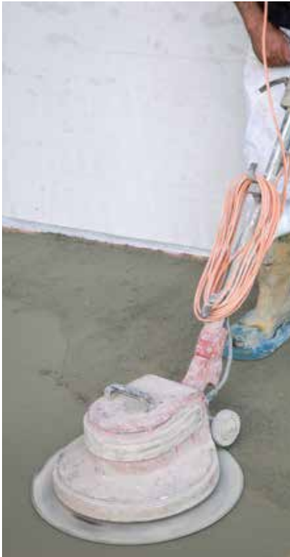
Estrich glätten mit Maschine
