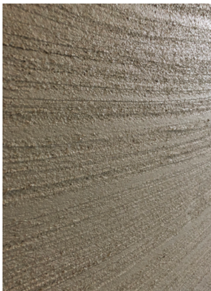
Fixit 454 mit Besen horizontal aufgerissen
