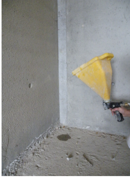
Mit Trichterpistole gespritzt
