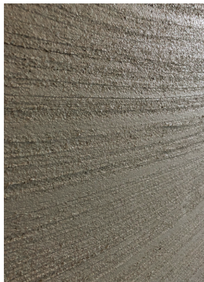
Fixit 454 mit Besen horizontal aufgerissen
