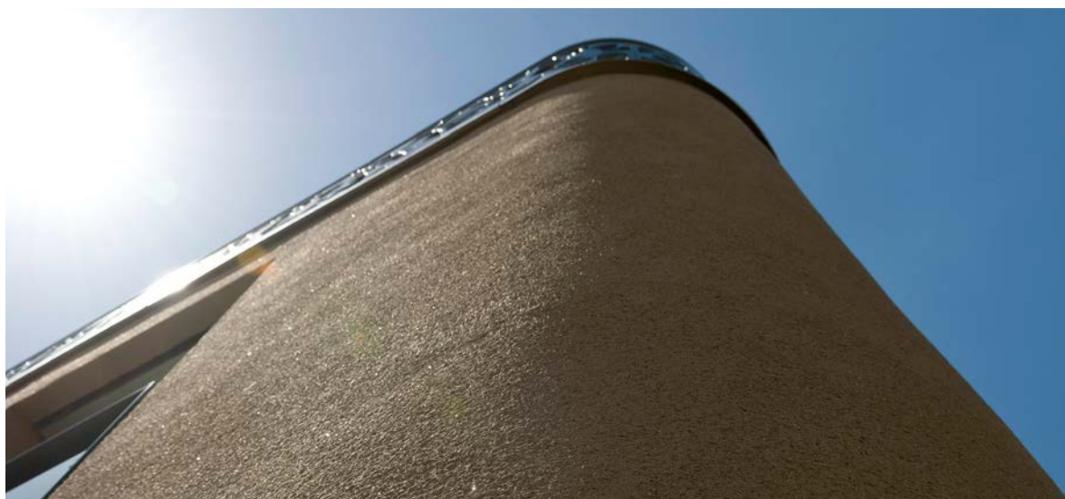
Immeuble d'habitation à Zurich Witikon, surface: 1348 m 2 . Structure du système: isolation avec laine de pierre, 240 mm; couche de fond Greutol Mortier d'enrobage light 425; enrobage du treillis Greutol Multiplan 407; couche de finition Greutol Enduit gratté light 585.
