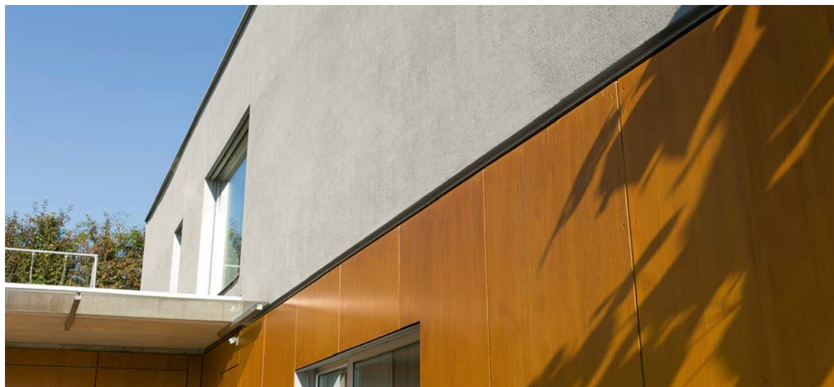
Immeuble d'habitation à Küsnacht, surface: 370 m 2 . Structure du système: isolation avec panneaux lamellaires en laine de pierre, 160 mm; couche de fond Greutol Mortier d'enrobage light 425; enrobage du treillis Greutol Multiplan 407; couche de finition Greutol Enduit de blanchiment light 590 et Enduit de finition résine silicone 361, 5.0 mm.
