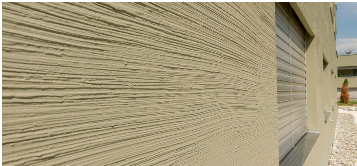
Immeuble d'habitation à Reinach, surface : 1800m 2 . Structure du système : isolation avec laine de pierre, 240 mm; enrobage du treillis Greutol Enduit Combi 488; couche de finition Greutol Enduit de finition silicone 365 extérieur plein, 1.0mm et 0.5 mm; peinture GreoColor OptiTop.
