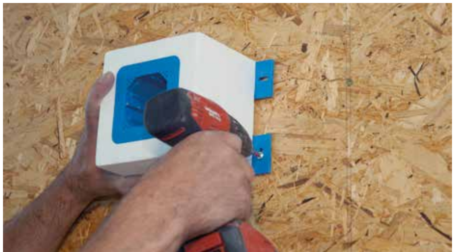
Pričvršćavanje montažnog elementa
