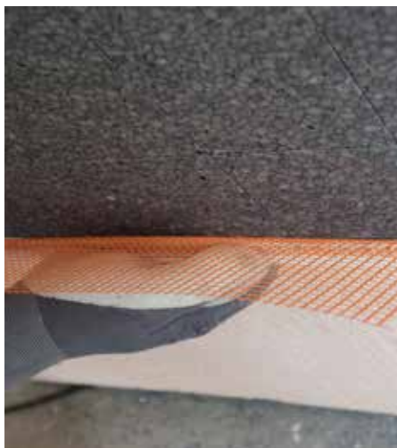
Umetanje RÖFIX spojnog profila za sokl
