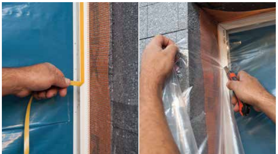
Uklanjanje žute trake sa samolepljive trake i lepljenje najlonske folije preko prozora
