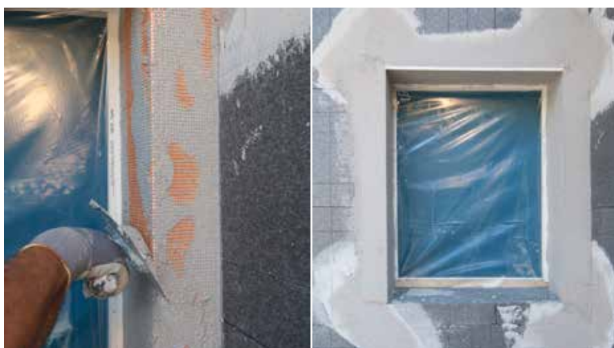
Umetanje ugaonih profila u svež malter
