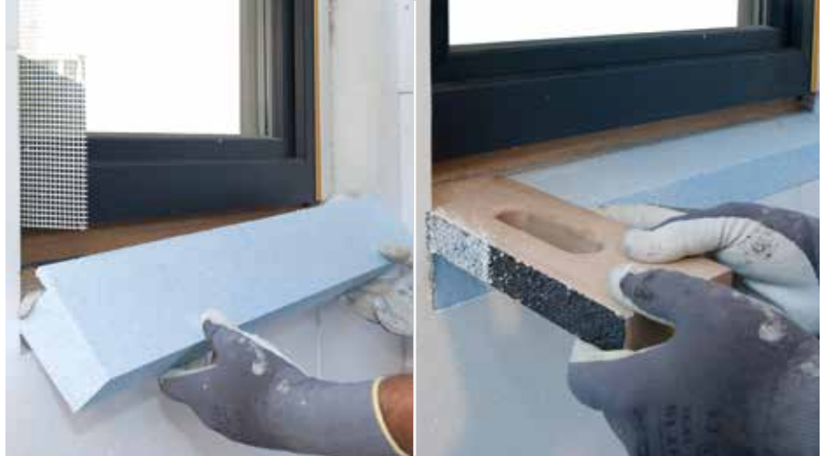
RÖFIX SOL-PAD Base zalepiti i izdubiti udubinu radi postavljanja priključnog profila za prozorsku klupicu
