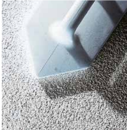
Malter za zaribavanje/malter žlebaste strukture – polistirenska gladilica za zaribavanje
