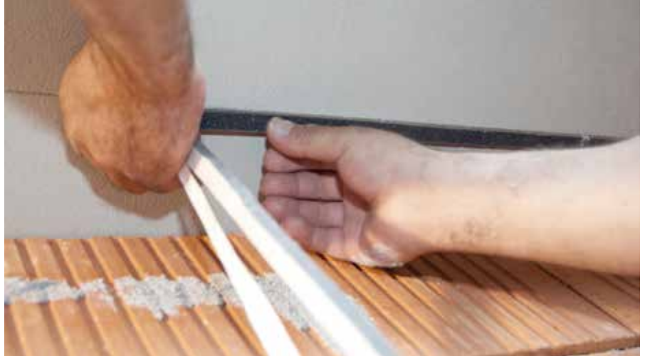
RÖFIX Izolacionu traku za fugne zalepiti ispod balkona
