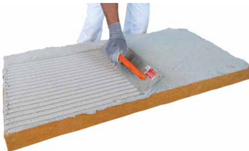
Lepljenje metodom „Floating-Buttering“ (punoplošno na poledinu izolacione ploče i površinu gde se lepi ploča)
