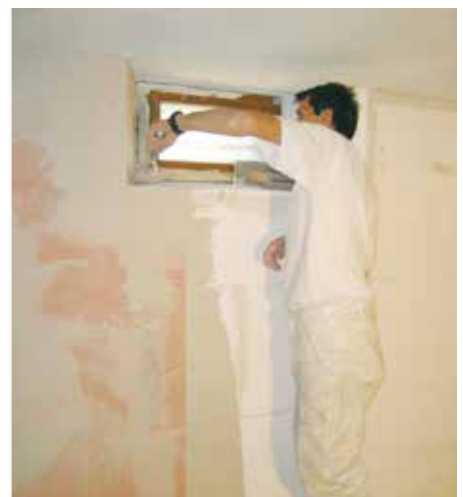
Postavljanje RÖFIX Renopor® Ivične premosnice
