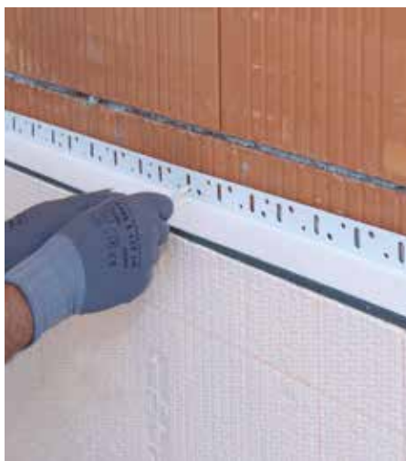
Pričvršćavanje RÖFIX baznog priključnog profila za sokl
