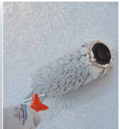
Premaz paropropusnim bojama
