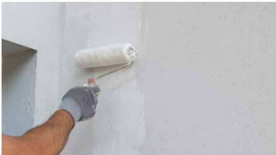
Temeljito nanošenje RÖFIX Predpremaza PREMIUM beli
