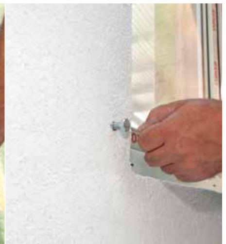
Pričvršćavanje montažnog elementa M-vijkom
