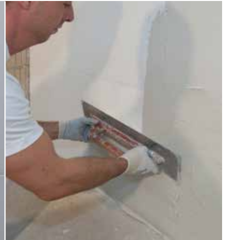
Armiranje RÖFIX Renopor® Specijalnim lepkom
