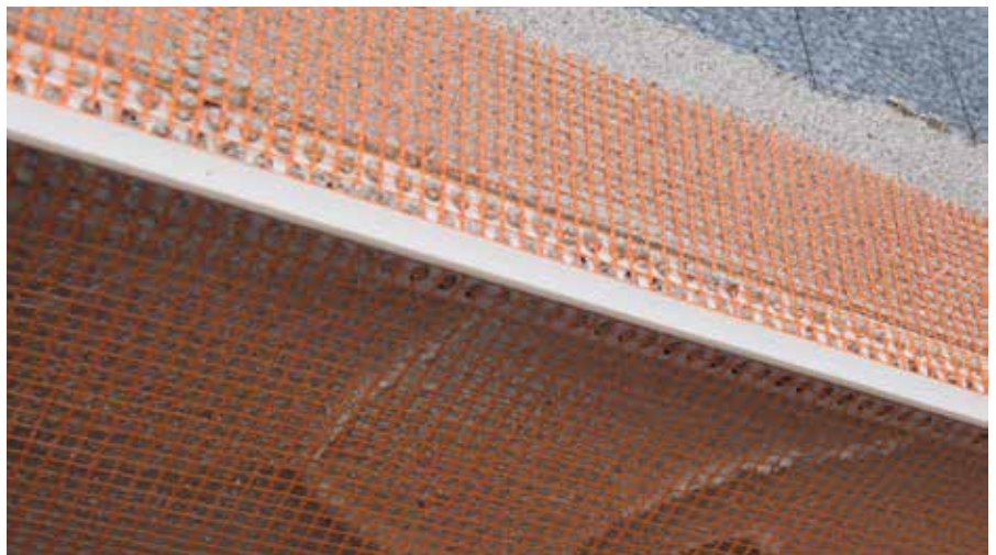
Okapni profil se polaže u svež malter za lepljenje i armiranje
