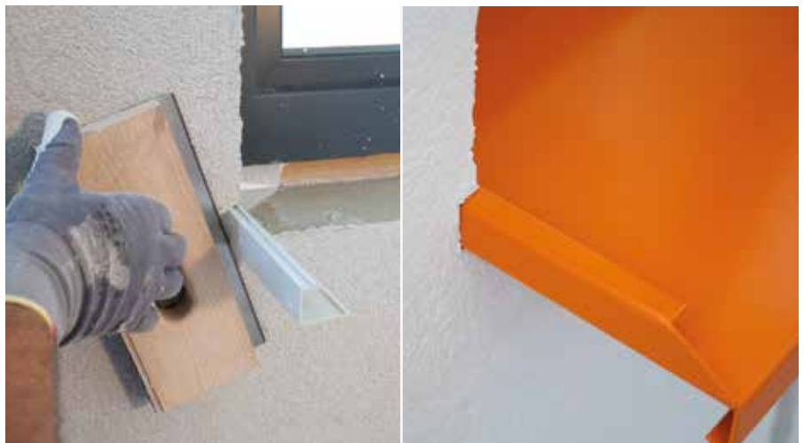
Rezanje viška RÖFIX SOL-PAD priključnog profila 2 mm od ivice i montiranje/umetanje prozorske klupice
