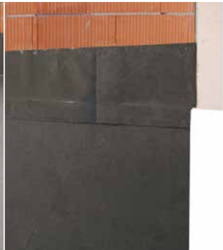
Hidroizolacija sokla bitumenskim trakama
