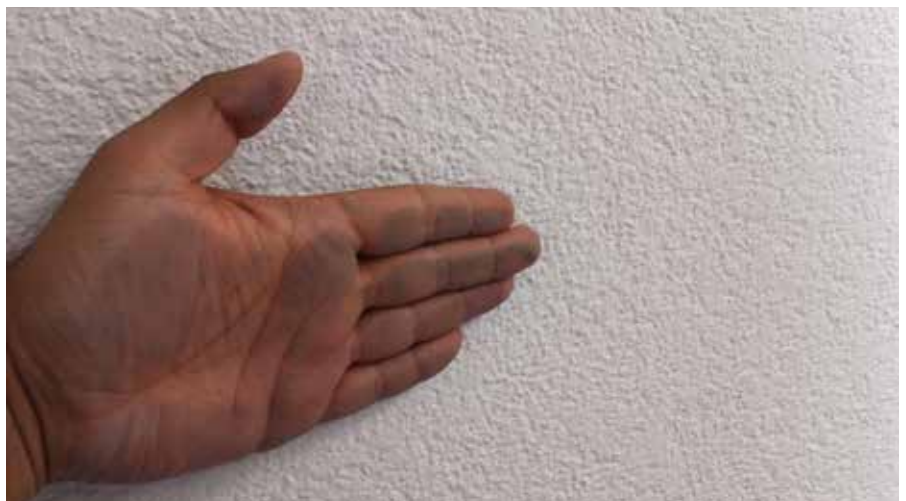
Prašnjave podloge sa kojih ostaje trag na ruci, otprašiti i grundirati razređenim RÖFIX PP 201 SILICA LF Silikatnim dubinskim predpremazom, a krečne premaze mehanički ukloniti
