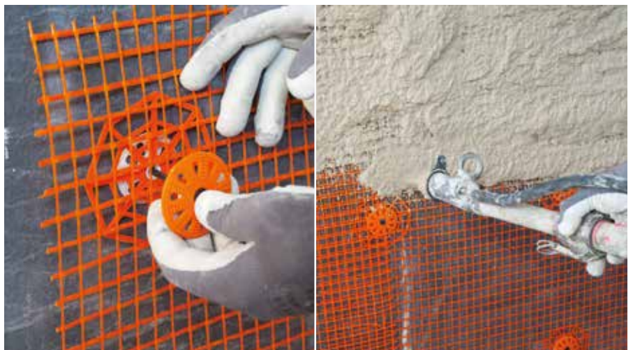
RÖFIX AR Zaštitnu mrežu postaviti i pričvrstiti korišćenjem RÖFIX BTH i RÖFIX NDF
