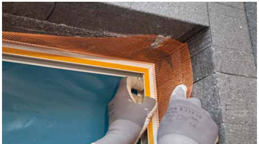
RÖFIX Profilne makaze PRO omogućuju precizno sastavljanje u uglovima prozora
