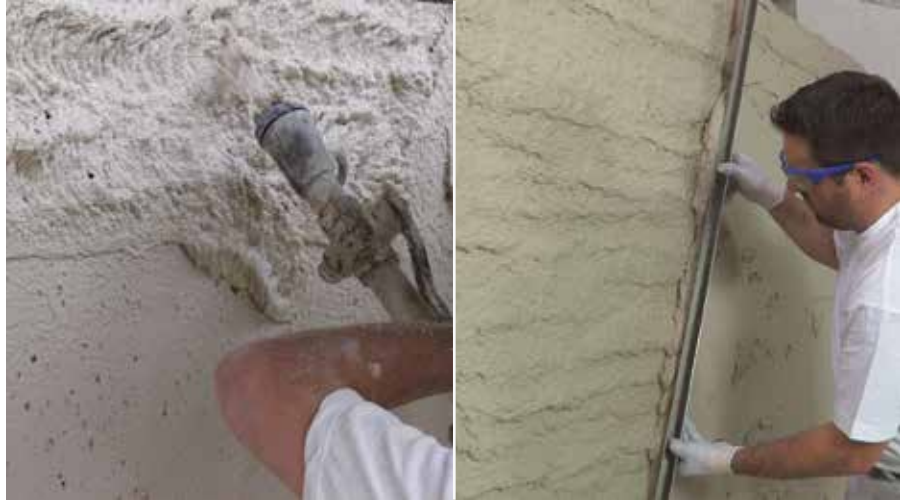
Nanošenje i izvlačenje/poravnavanje FIXIT 222 Aerogel izolacionog maltera
