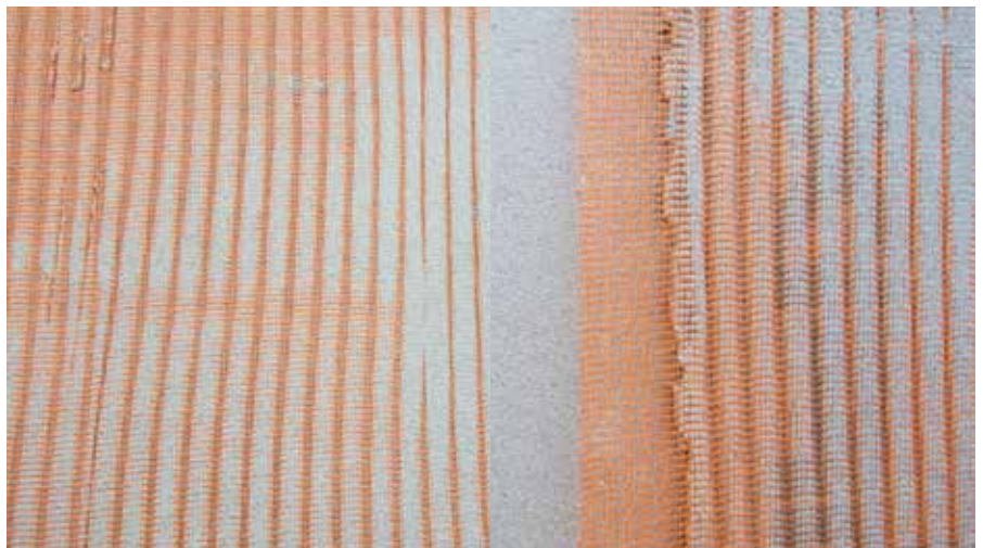
Ispod VOSS \leq 20 % površina se dvostruko armira sa dva sloja RÖFIX P50
