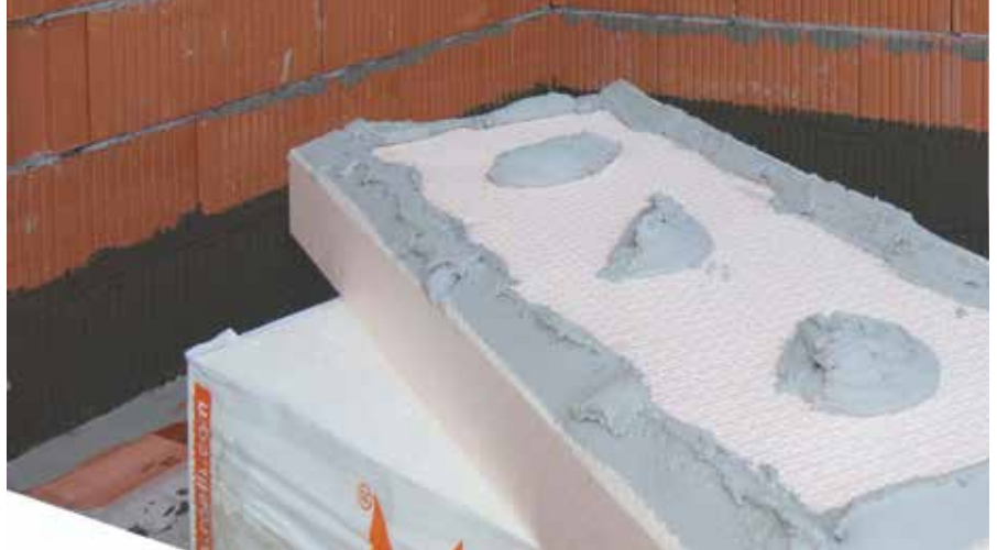
Lepljenje RÖFIX EPS-P 035 Izolacionih ploča za sokl sa RÖFIX Optiflex® 1K ili 2K
