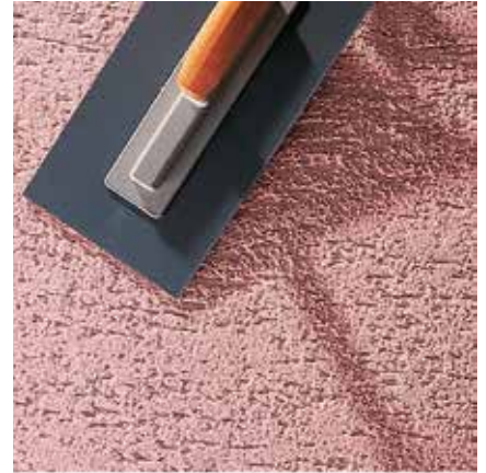
Malter za zaribavanje/malter zrnaste strukture – plastična (PVC) gladilica
