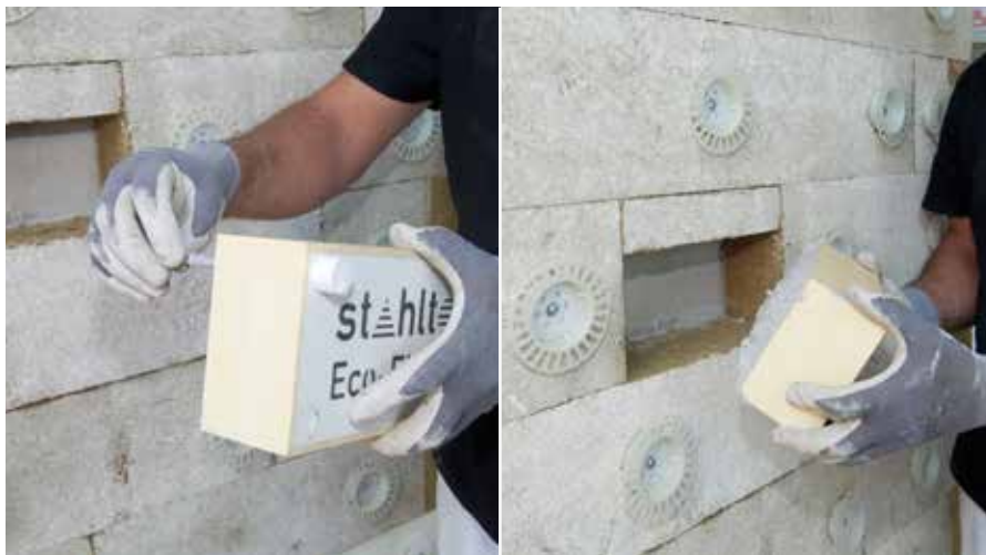
Uklanjanje EPS čepova
