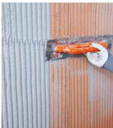
Armirajući sloj se izvodi u ND od 5 mm
