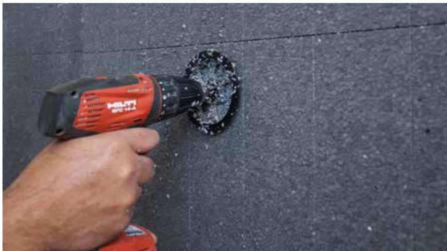
Izvođenje otvora RÖFIX Dorondo - alatom za glodanje
