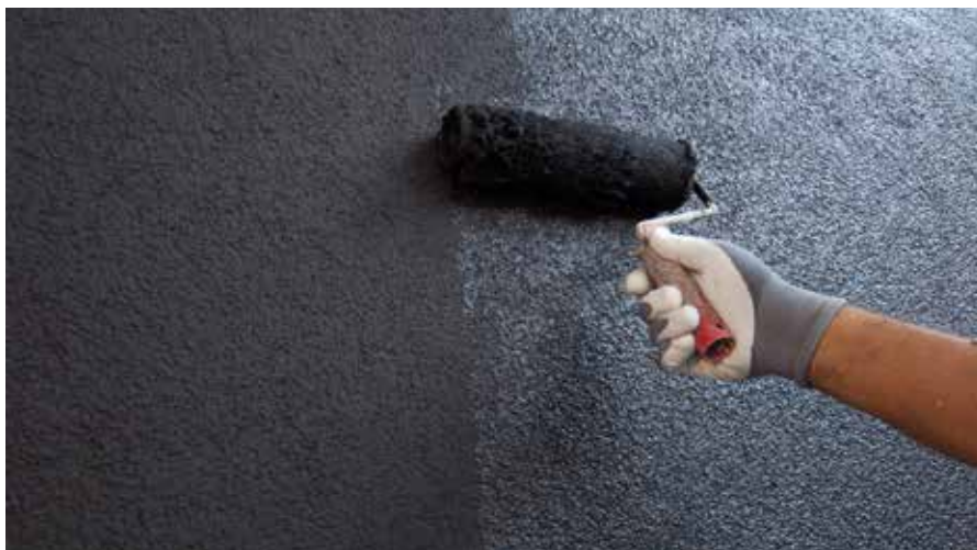
Dvostruki premaz RÖFIX PE 519 PREMIUM DARK
