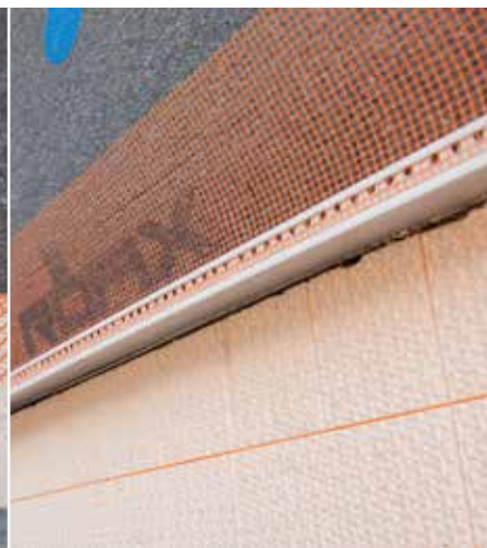
Izgled završenog, nepropusnog spojnog profila za sokl sa ugrađenim okapnim profilom pre malterisanja
