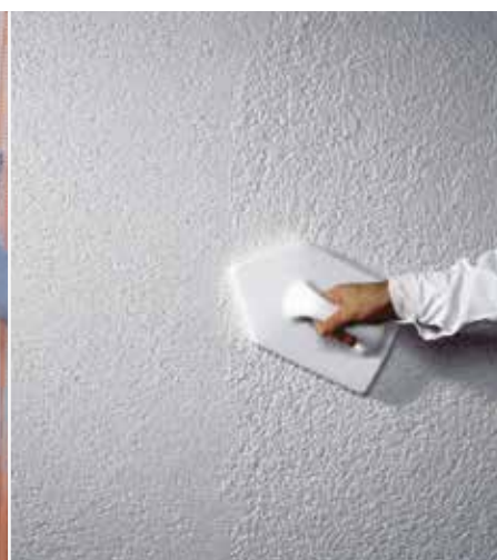
Nakon proteklog vremena sušenja nanosi se završni sloj u željenoj strukturi
