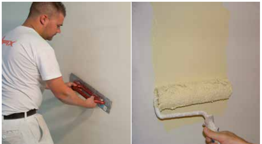
Nanošenje pokrovnog maltera
