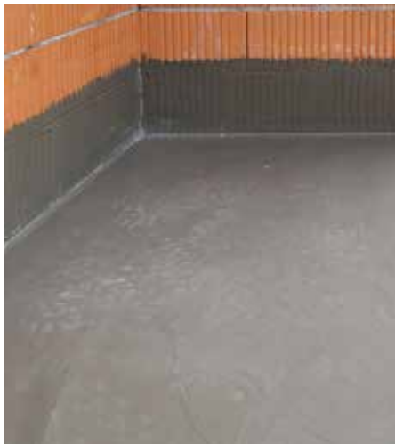
Izolacija sokla i terase RÖFIX Optiseal® -om
