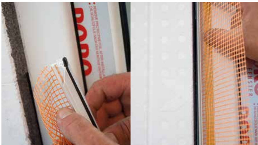
Razrezani profil čvrsto zalepiti na očišćene prozorske okvire (tik uz izolacionu ploču)
