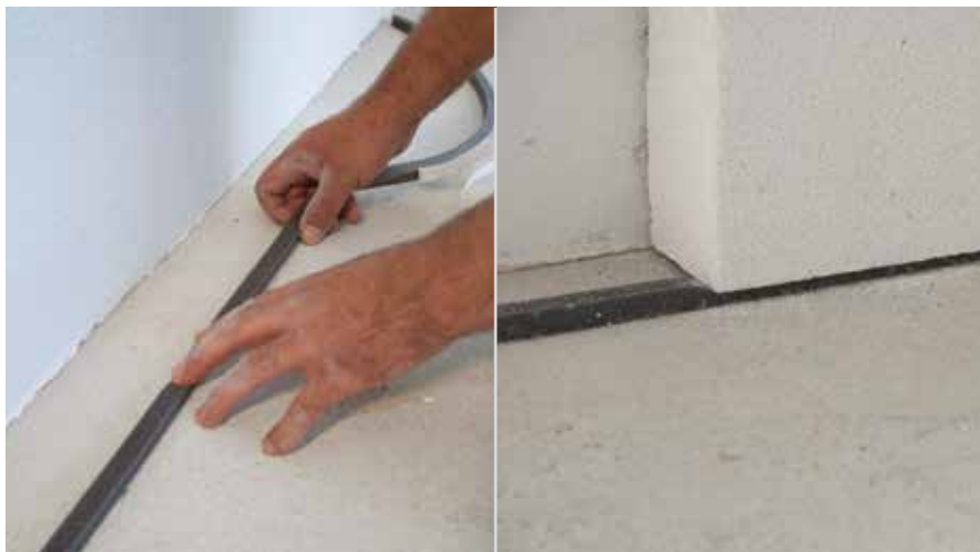
Unutrašnji izolacioni sistem se u podu, plafonu i zidu zatvara RÖFIX Izolacionom trakom za fugne
