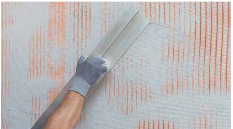
Umetanje RÖFIX P50 Staklene mrežice u sveže pročešljan malter
