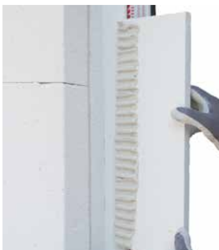
Izbegavati ostatke lepka u dodirnim fugnama
