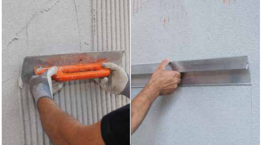
Nanošenje maltera zupčastim gleterom u ravnim linijama i utiskivanje RÖFIX P50 Staklene mrežice. Izravnavanje površine aluminijumskom letvom
