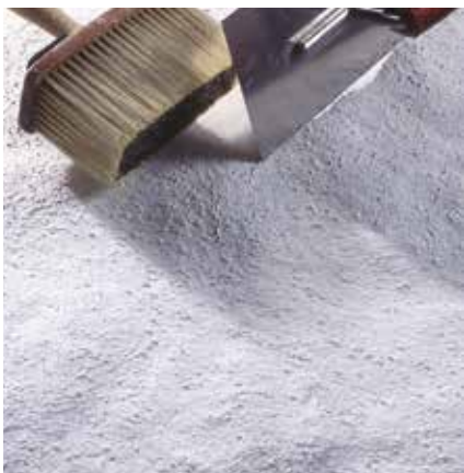
Malter za modelovanje-/Retki rustikalni malter – molerska četka
