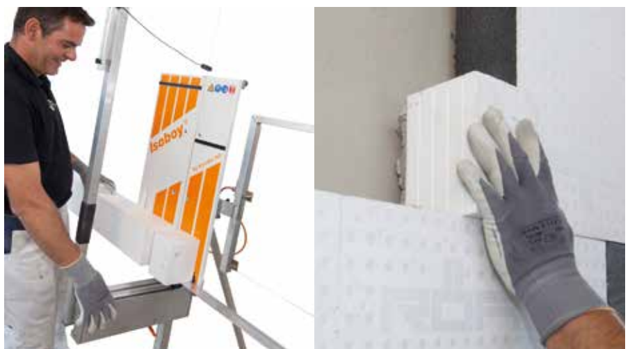
Precizno rezanje RÖFIX Quick-Quader EPS montažnog elementa sa RÖFIX ISOBOY GD 34 i lepljenje u sistemu ispitanim, malterom za lepljenje i armiranje
