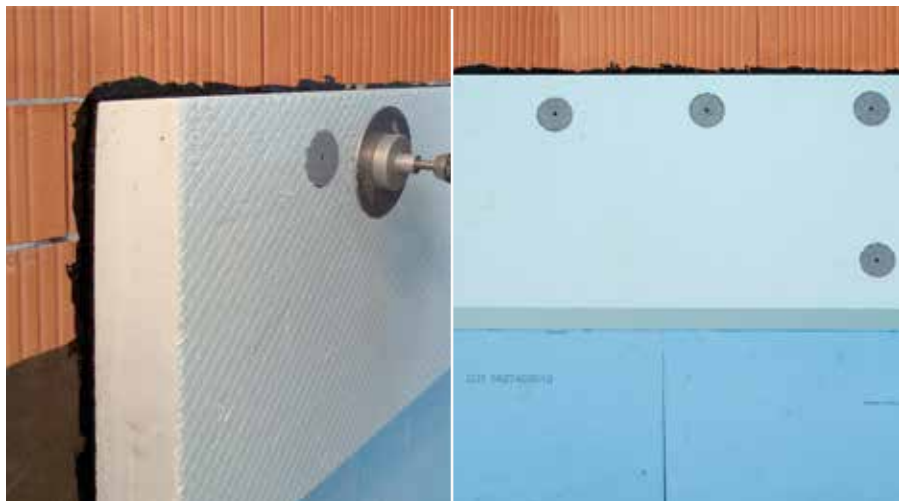
Pričvršćavanje ispod gornje ivice izolacionih ploča za sokl pomoću 2 tipla/ploči
