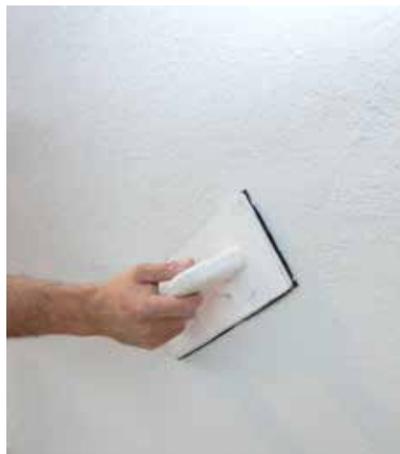
Strukturisanje RÖFIX Renopor® Specijalnim lepkom
