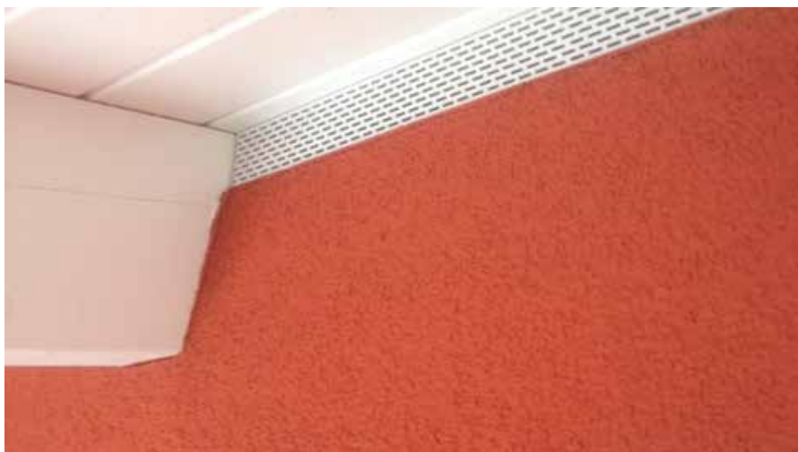
Izgled ugrađenog i omalterisanog RÖFIX završnog profila krova
