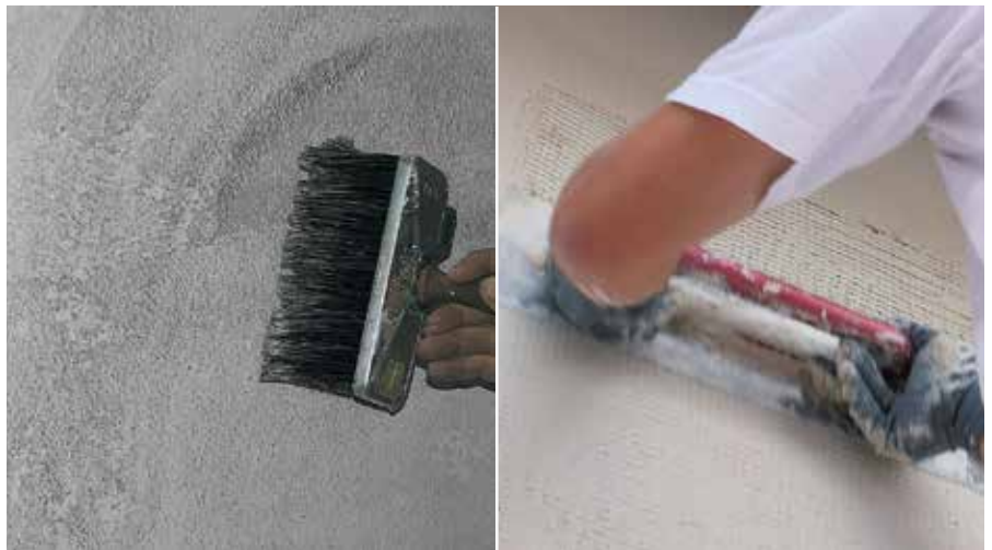
Učvršćavanje podloge s RÖFIX PP 201
