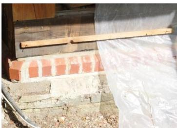
Auf dem Natursteinsockel sitzt jetzt eine Lage vorne abgeschrägter Vollziegel, gefolgt von einer Bitumen-Horizontalsperre und neuen Schwellhölzern aus Eiche.
