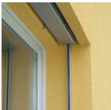
Raccordi di facciata a tenuta di pioggia battente ed elementi di montaggio razionali
