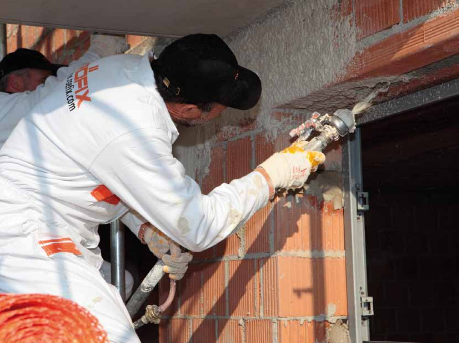
Hohlstellen im Putz müssen abgeschlagen und mit Grundputz ausgeglichen werden.
