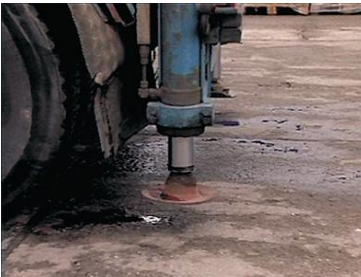
Fot. 5 Płyty muszą być ułożone na stabilnym podłożu i dokładnie wypoziomowane, aby ustawiony na nich silos nie przewrócił się. Płyty drogowe są także miejscem oparcia dla podpór stabilizujących samochód ciężarowy podczas ustawiania silosu w pozycji pionowej. W celu szybkiego i bezpiecznego ustawienia silosu zalecane jest ułożenie kilku segmentów płyt drogowych tworzących utwardzony plac pod silosy i krótką drogę dojazdową do miejsca ustawienia silosu, co zapobiega zapadaniu się w grunt kół samochodu ciężarowego podczas manewrowania.
