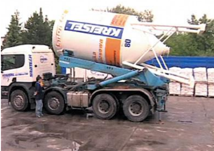
Fot. 4 Technika silosowa polegająca na transporcie materiałów sypkich za pomocą silosów umożliwia ograniczenie obsługi technicznej tylko do jednej osoby. Kierowca samochodu przewożącego silos jest jednocześnie operatorem urządzenia umożliwiającego ustawienie silosu w pozycji pionowej. Najprostszym a jednocześnie wystarczającym sposobem zapewnienia właściwych warunków dla oparcia nóg silosu jest ułożenie betonowych płyt drogowych służących do tworzenia prowizorycznych dróg na placach budów.
