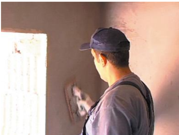
Fot. 13 Końcowym etapem prac tynkarskich jest precyzyjne wygładzenie powierzchni wyprawy.
