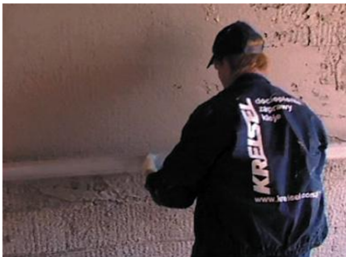
Fot. 12 Po nałożeniu tynku następuje jego wyrównanie za pomocą długiej łąty typu „H”.
