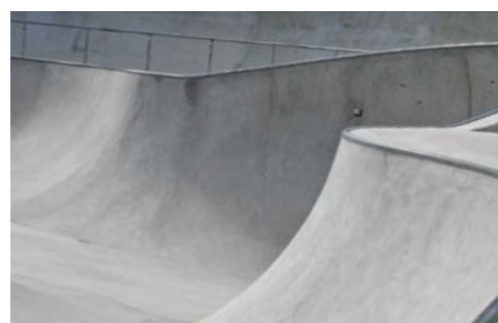
Betoni in nizkogradnja
