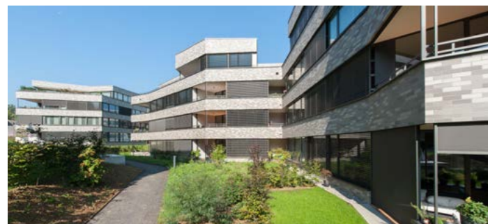
Stanovanjska zgradba, kanton Binningen
