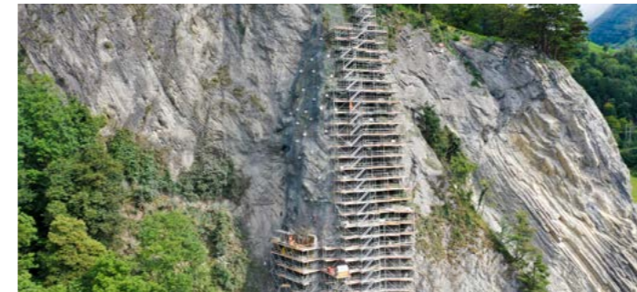
Zavarovanje sten na cesti Axenstrasse, Sisikon (Uri)
