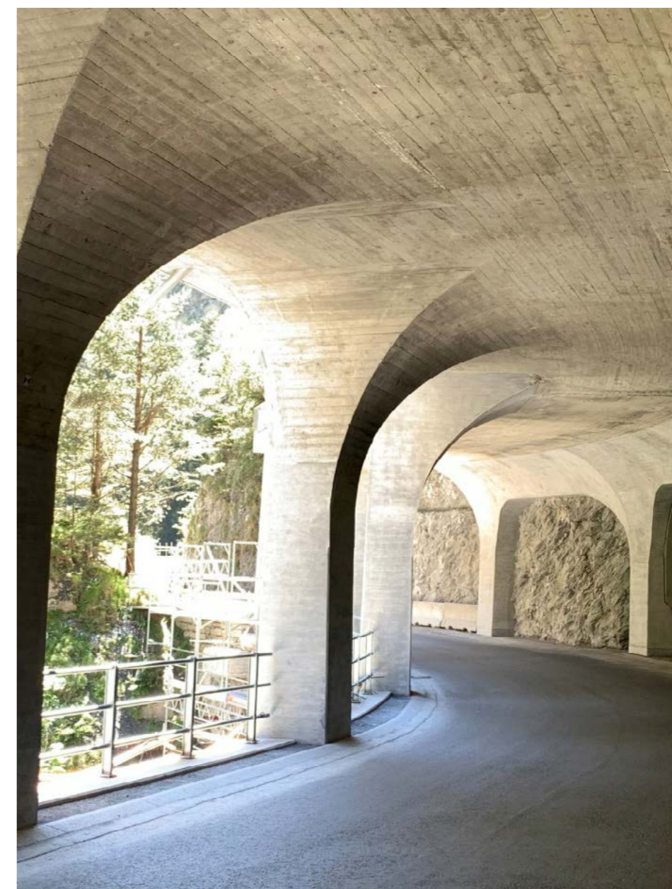
Sanacija »Galerija Viamala 1«, Švica
