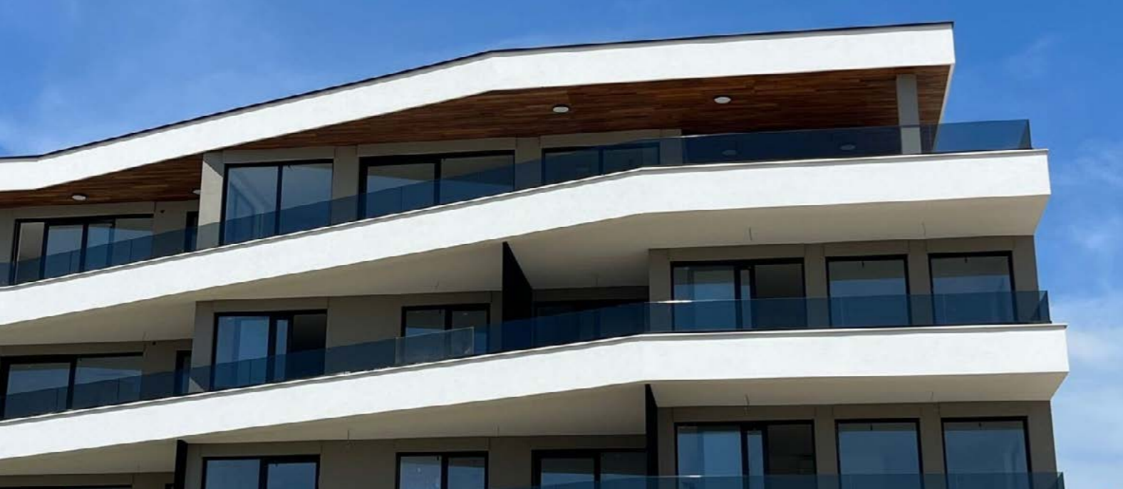
Stanovanjska stavba, Vabriga, Hrvaška
