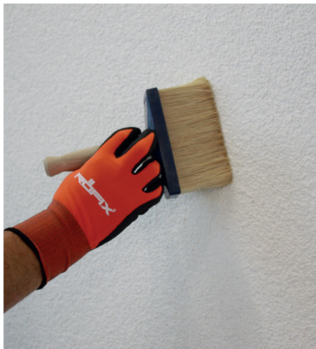
Priprava nosilne podlage
