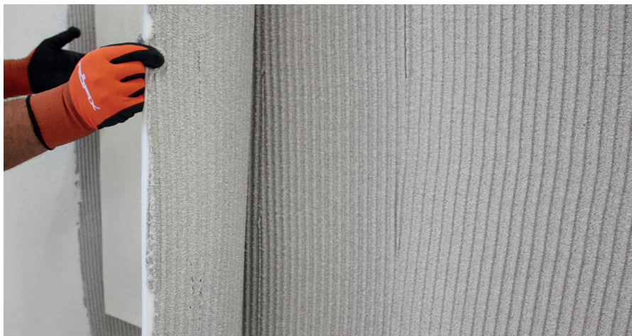
Lepljenje toplotnoizolacijskih plošč po postopku buttering-floating
