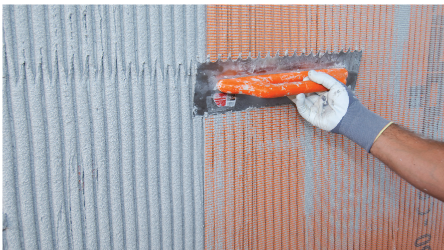
Izdelava armiranega osnovnega ometa
