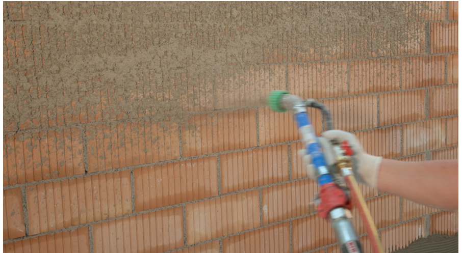
Priprava podlage z običajnim strojem za omete
