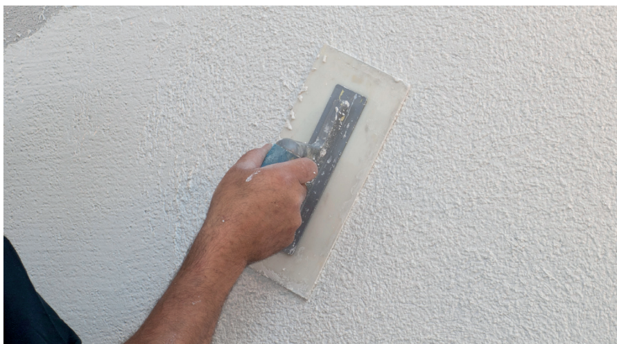
Nanesite RÖFIX zaključni omet in ga po želji strukturirajte
