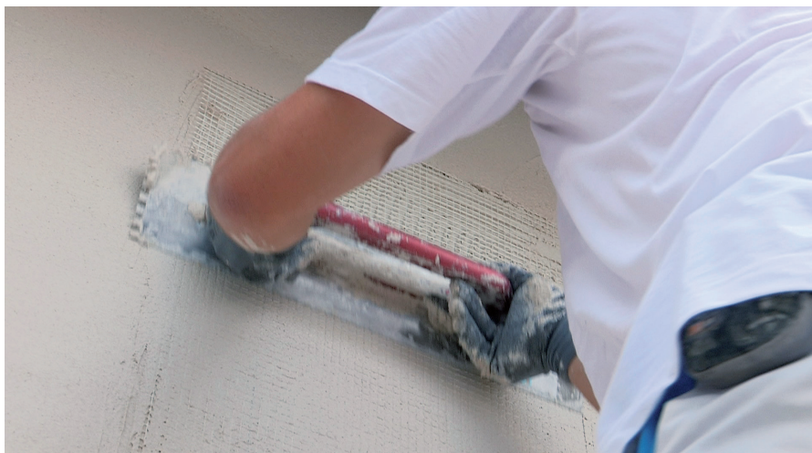
Vgradnja mrežice z malto za armiranje
