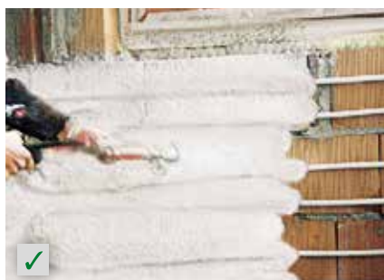
Incorporazione del riscaldamento a parete nell'intonaco RÖFIX Renoplus®
