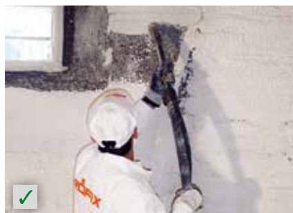
Livellamento del supporto prima del rivestimento definitivo (nuova pittura, rivestimento murale) RÖFIX Renoplus®
