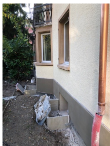
Der Sockel wurde mit Fixit 455 Zementhaftputz neu überzogen.
