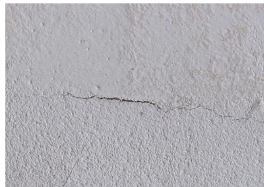
Fissure d'affaissement
