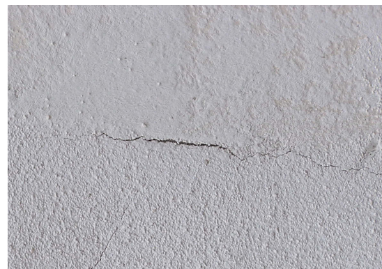
Fissure d'affaissement
