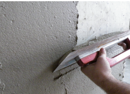
Appliquer un spatulage d'assainissement
