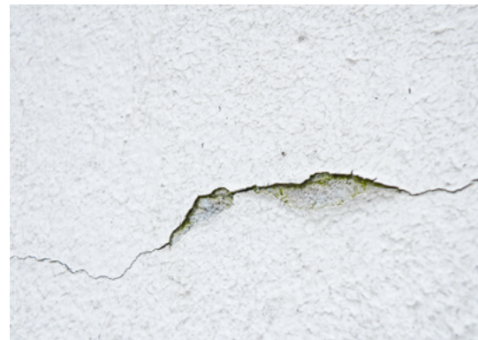
Décollement / fissuration du crépi
