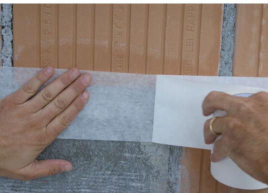
Coller le non tissé de séparation
