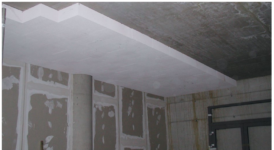
Platten sofort an der Deckenoberfläche einschwimmen
