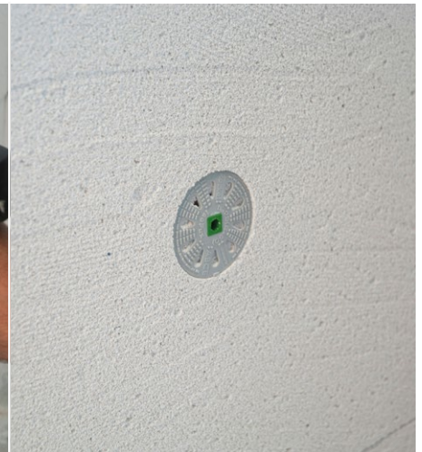
Dübel oberflächenbündig eingeschraubt
