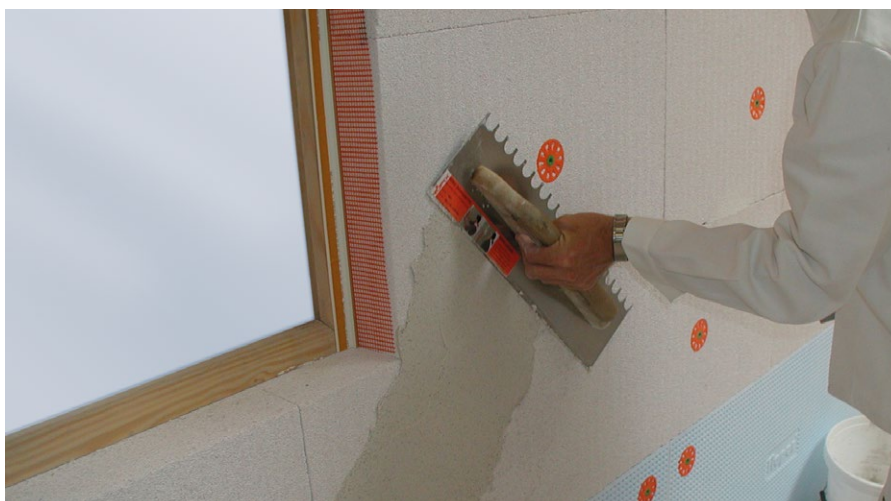
Diagonalarmierung
