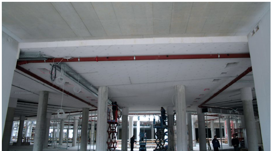
RÖFIX MULTIPOR Dämmplatten an die Decke kleben
