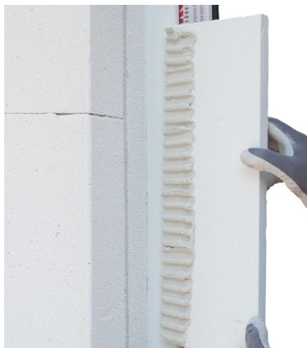
Kleber in Stoßfugen ist zu vermeiden
