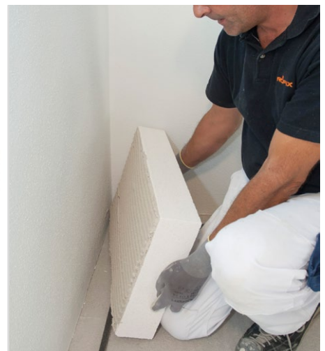
Die Dämmplatte beim Verlegen gut einschwimmen
