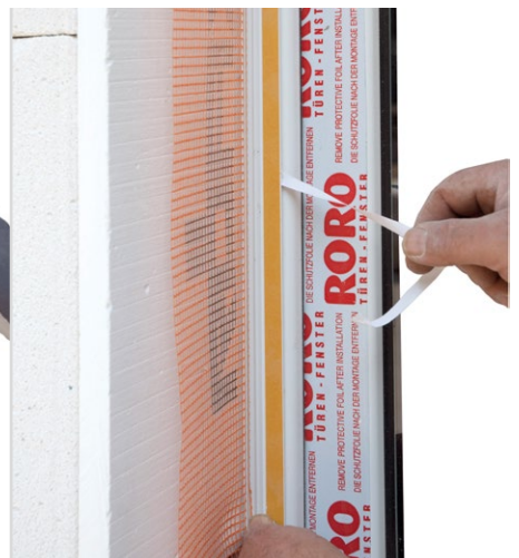
RÖFIX APL 3D Membran Reno auf den Fensterrahmen kleben und das Fenster vor dem Verputzen abkleben
