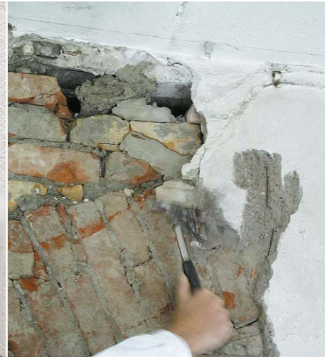
Lose Untergründe entfernen
