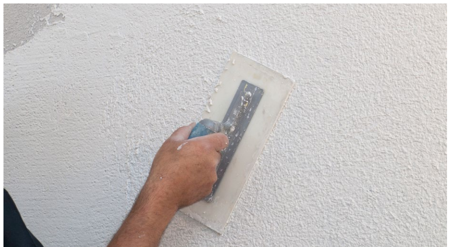
Oberputz nach Wunsch strukturieren
