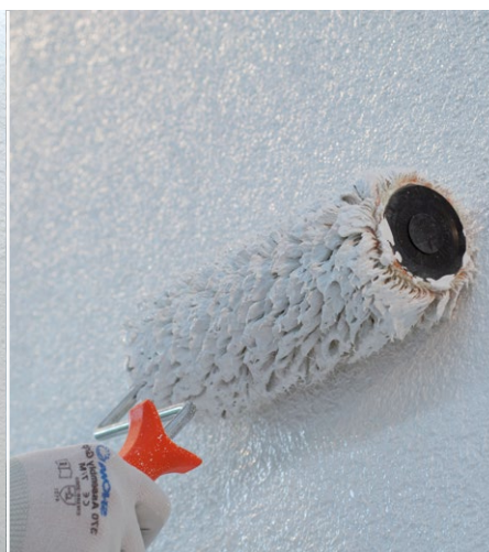
Beschichten mit dampfdiffusionsoffenen Farben
