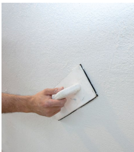
Strukturieren mit RÖFIX MINOSTAR® Klebespachtel
