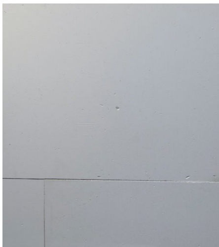
Fugen stumpf gestoßen
