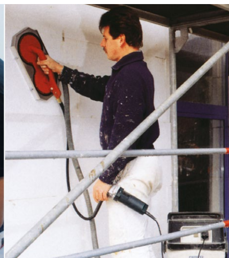
Unebenheiten durch Schleifen ausgleichen
