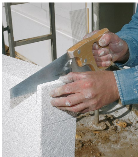
Schneiden/Handsäge
