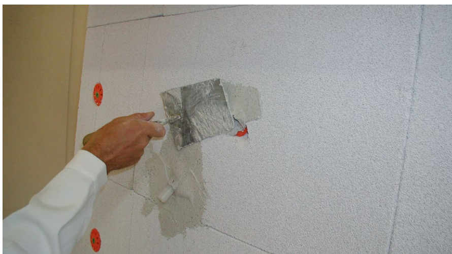
Plattenausbrüche füllen
