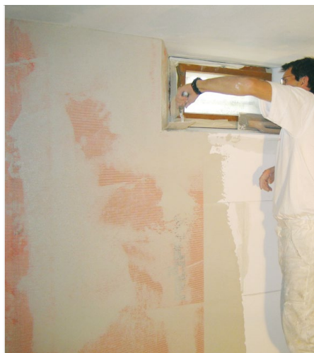
Montage mit RÖFIX Renopor® Anpasskeil
