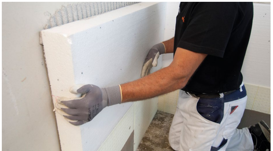
Dämmplatten kleben
