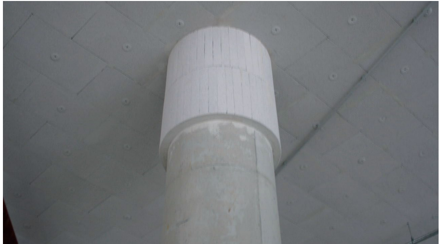
Anschluss an eingebundene Bauteile
