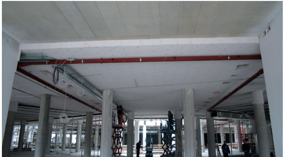
RÖFIX MULTIPOR Dämmplatten an die Decke kleben
