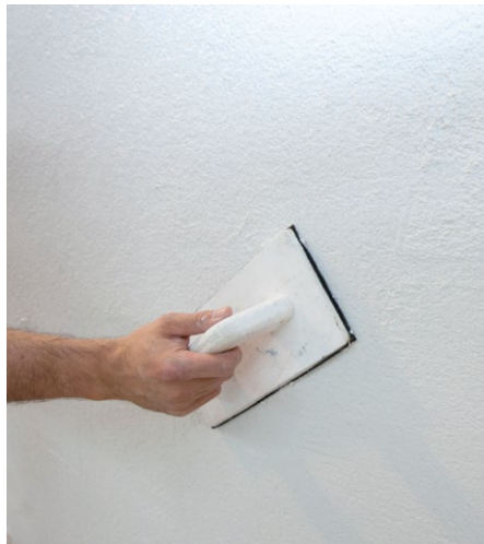
Strukturieren mit RÖFIX MINOSTAR® Klebespachtel
