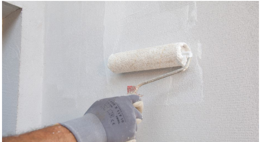
Für pastöse Oberputze: RÖFIX Putzgrund PREMIUM satt deckend aufrollen und mindestens 12 Stunden trocknen lassen
