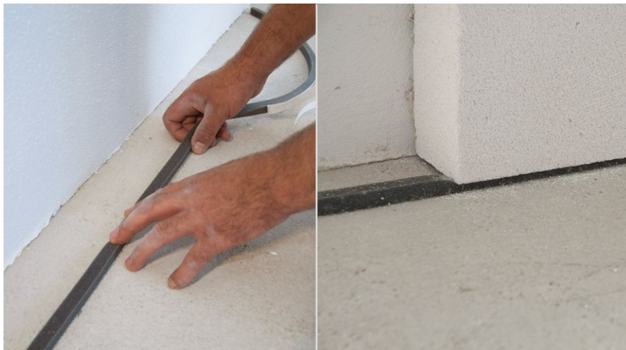
Innendämmsystem gegen den Boden, die Wand und die Decke mit RÖFIX Fugendichtband abschließen
