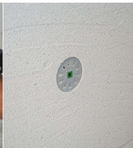
Dübel oberflächenbündig eingeschraubt
