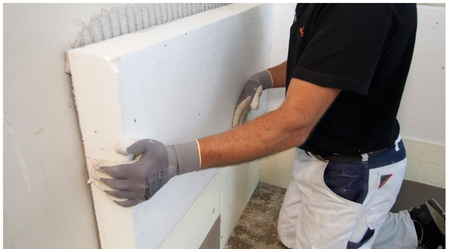
Dämmplatten kleben
