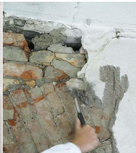
Lose Untergründe entfernen
