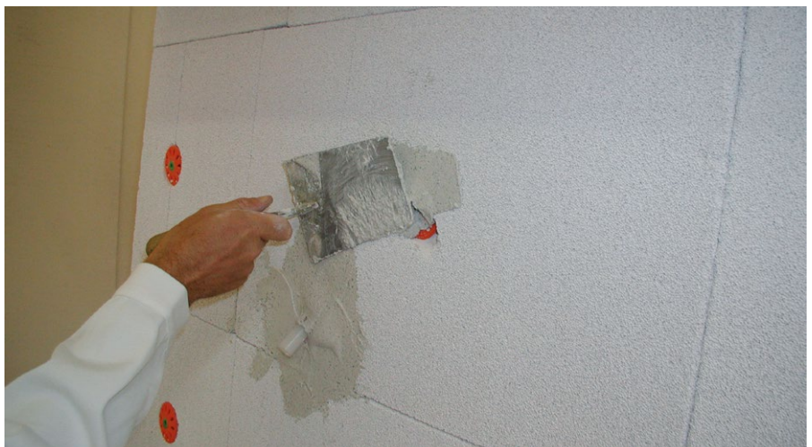
Plattenausbrüche füllen
