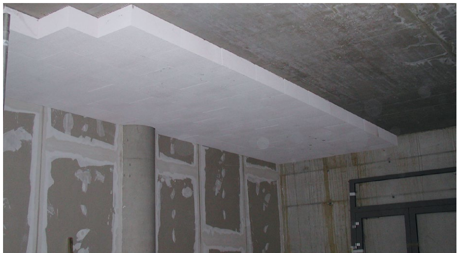
Platten sofort an der Deckenoberfläche einschwimmen
