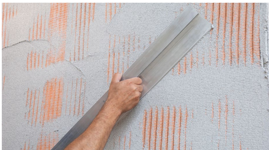
Mit der Putzlatte kann eine ebene Oberfläche abgezogen werden
