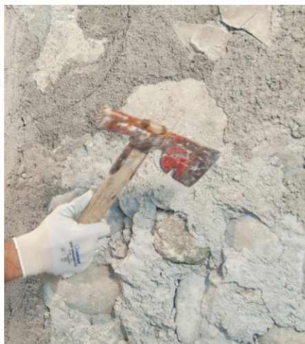
Abschlagen des Altputzes
