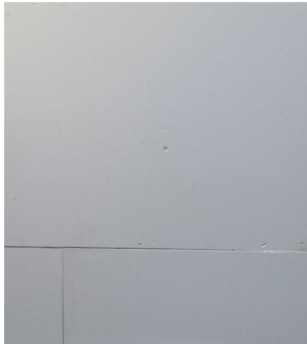
Fugen stumpf gestoßen
