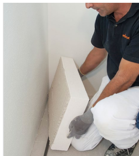
Die Dämmplatte beim Verlegen gut einschwimmen
