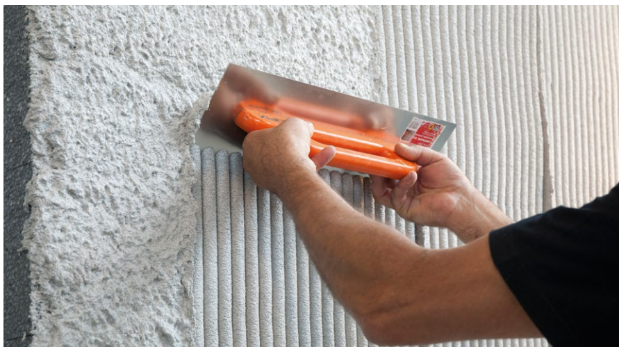
Unterputz aufziehen und in gleichmäßigen Wulstbahnen aufkämmen
