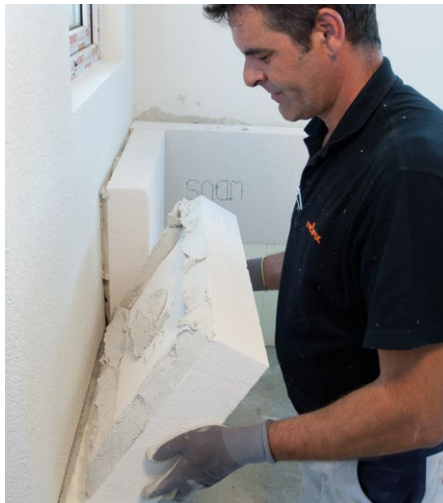
Dämmplatten verlegen
