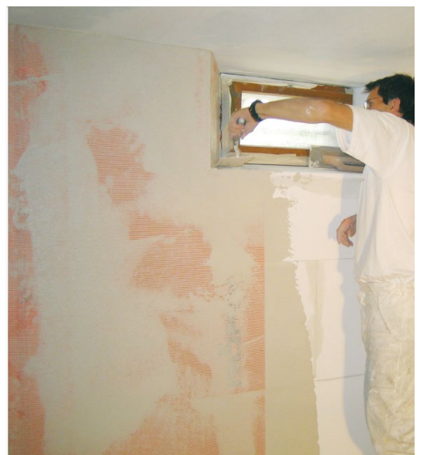
Montage mit RÖFIX Renopor® Anpasskeil
