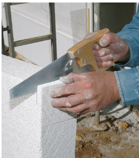
Schneiden/Handsäge
