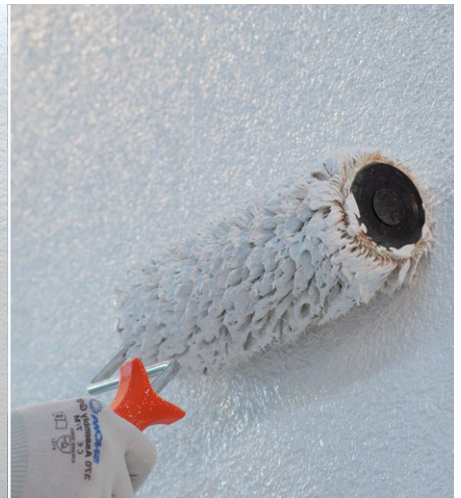
Beschichten mit dampfdiffusionsoffenen Farben
