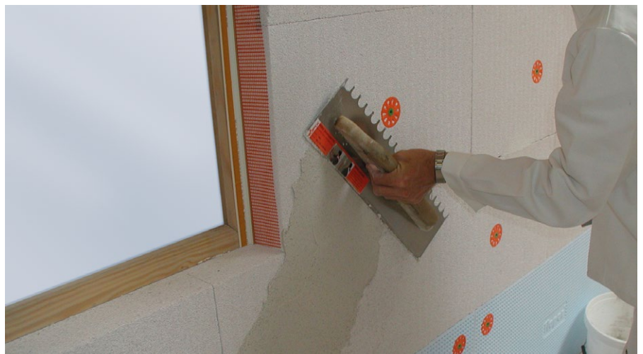
Diagonalarmierung
