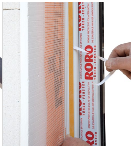
RÖFIX Mini 3D auf den Fensterrahmen kleben und das Fenster vor dem Verputzen abkleben
