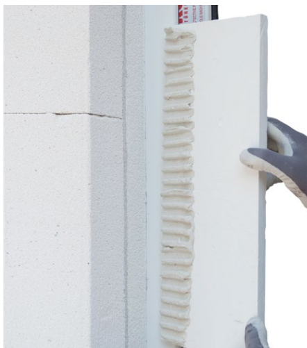
Kleber in Stoßfugen ist zu vermeiden
