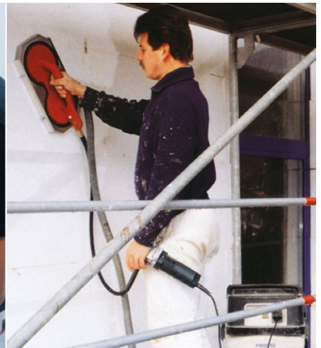
Unebenheiten durch Schleifen ausgleichen
